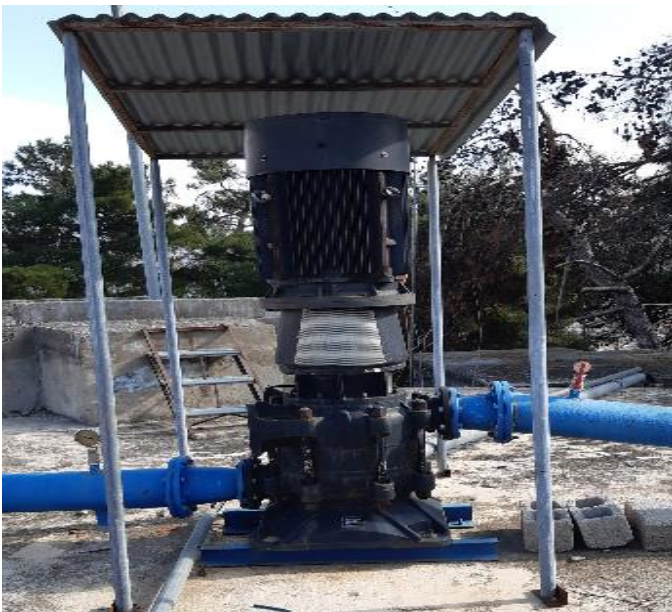
ΣΧΗΜΑ 4.3: Φωτογραφική απεικόνιση μια τυπικής φυγοκεντρικής αντλίας η οποία χρησιμοποιείται σε δίκτυο ύδρευσης προκειμένου να αυξάνει το μανομετρικό ύψος (λειτουργία booster).
