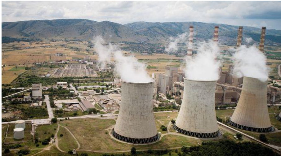
Εικόνα 2.1: Θερμική μονάδα παραγωγής ηλεκτρικής ισχύος στην Πτολεμαΐδα.
