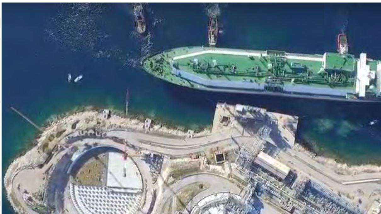
Εικόνα 1.6 LNG Terminal Ρεβυθούσας (Πηγή: Huffington Post)
