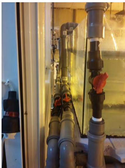
Εικόνα 4. Συνδεσμολογία πλαστικών ρακόρ που χρησιμοποιήθηκαν για τη ρύθμιση της παροχής στο σύστημα ενυδρείοπονίας (Πηγή: Προσωπικό αρχείο).
