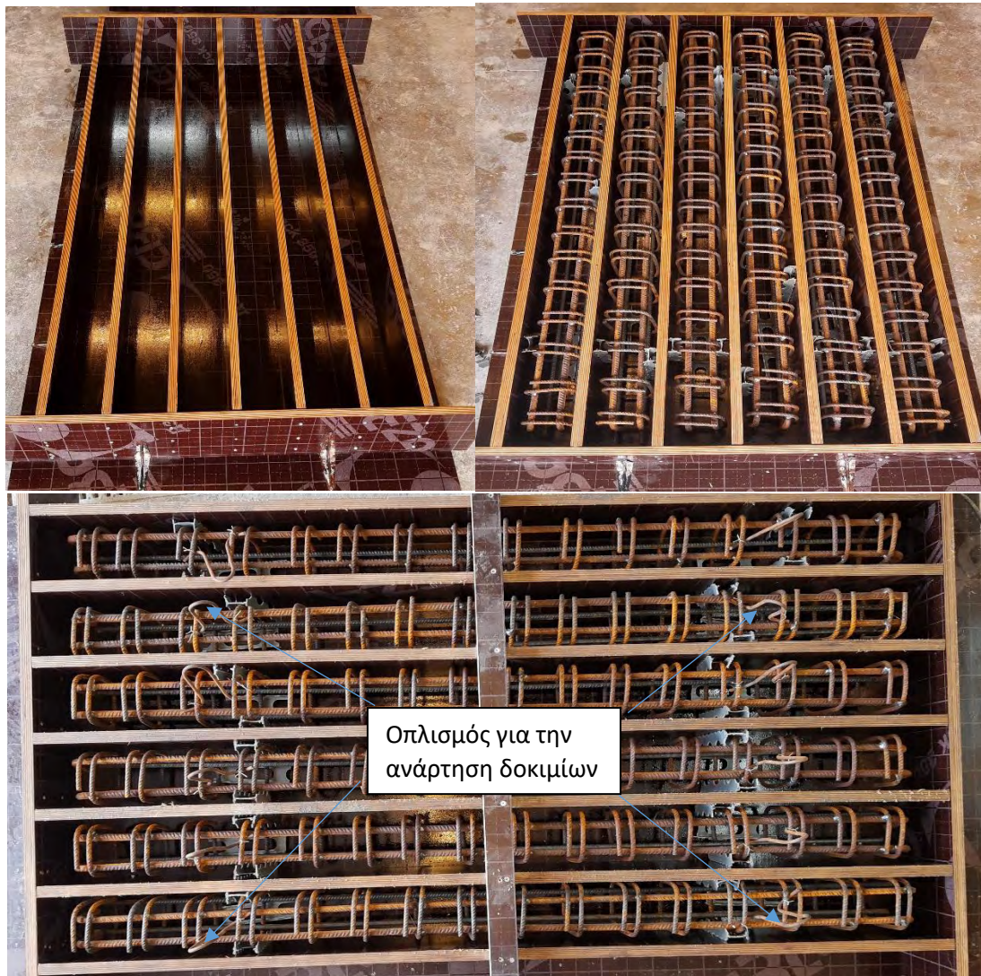
Εικόνα 3.6 : 1 η εικόνα πάνω και αριστερά είναι τα καλούπια χωρίς οπλισμό, 2 η εικόνα πάνω και δεξιά αριστερά είναι τα καλούπια με οπλισμό και η κάτω εικόνα είναι τα καλούπια με την προσθήκη γάτζων.
