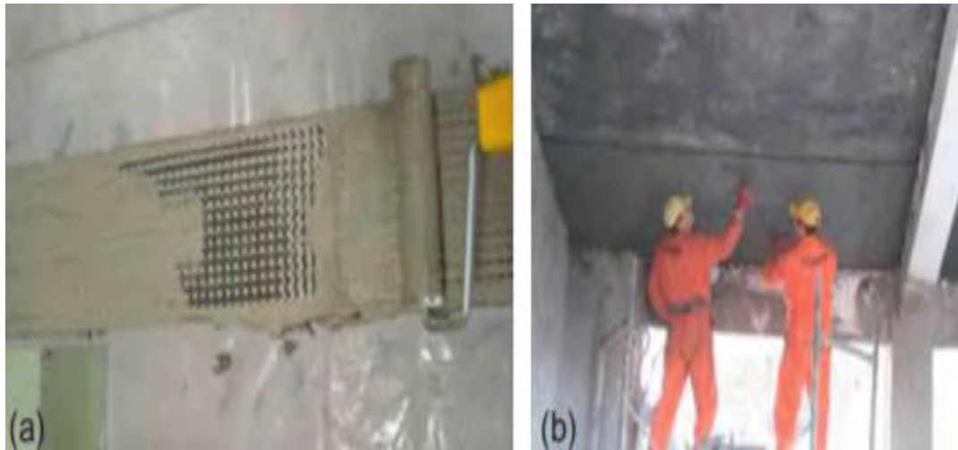
Εικόνα 2.13: (a) Καμπτική ενίσχυση με TRM σε δοκούς και (b) πλάκες, Triantafyllou (2016)
