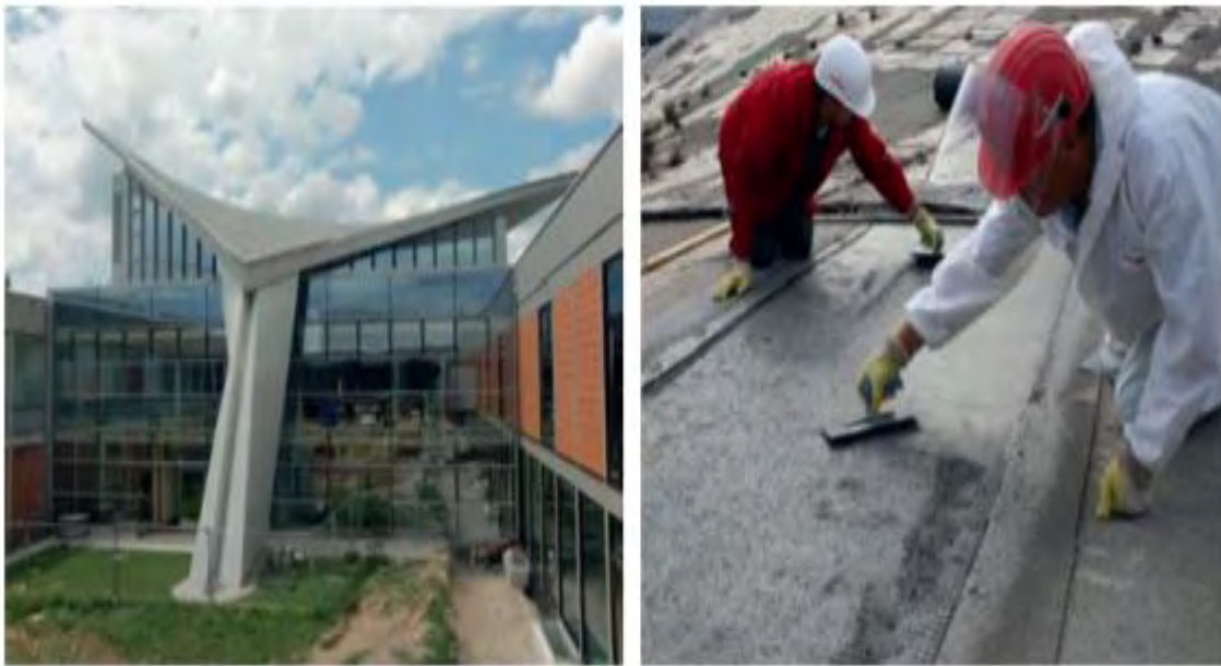
Εικόνα 2.12: Ενίσχυση κελύφους με TRM ,Raupach et al. (2016)
