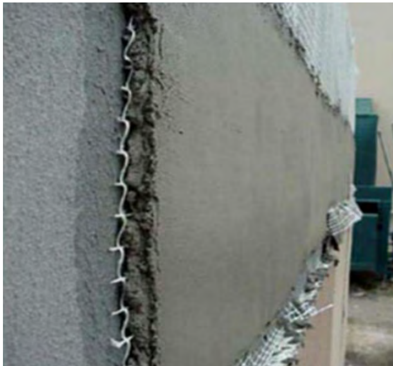
Εικόνα 2.6: Χρήση τσιμεντοκονιάματος ως μήτρα ινοπλέγματος, Μπαλιούκος (2008)
