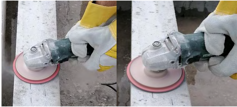
Εικόνα 3.15 : Στιγμιότυπα τροχίσματος επιφάνειας ενίσχυσης.
