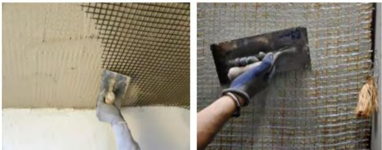
Εικόνα 2.8: Εμποτισμός του TRM με κονία μέσω σπάτουλας, Δερουκάκη (2019)
