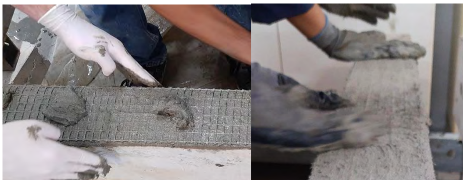
Εικόνα 3.20 : Στιγμιότυπα επάλειψης κονιάματος
