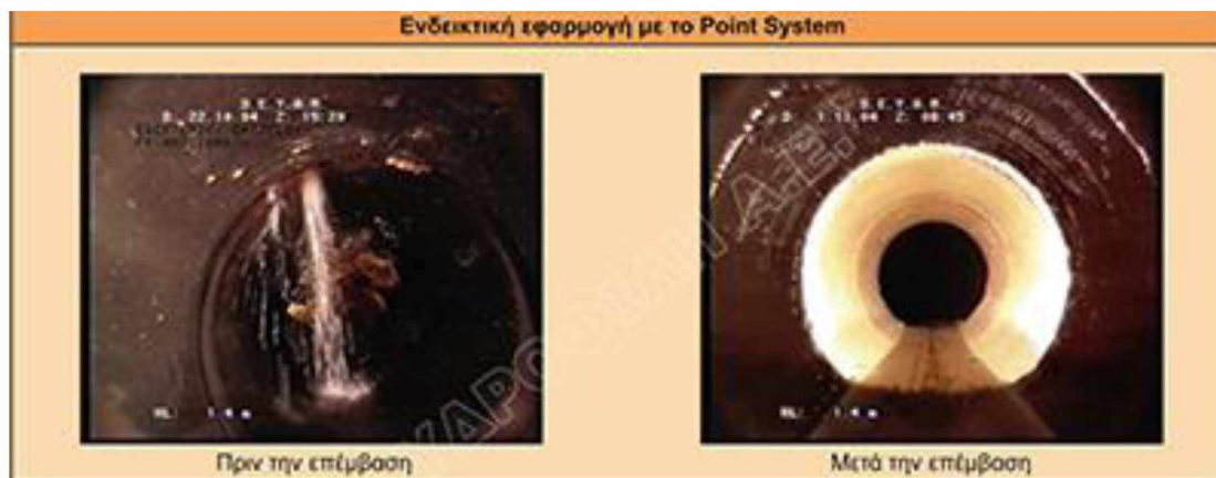
Εικόνα 3.11: Ενδεικτική εφαρμογή με το Point system πριν και μετά την επέμβαση
