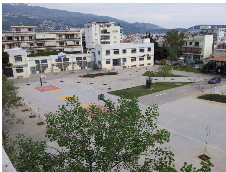
Εικόνα 1. Καταγραφή υφιστάμενης κατάστασης
