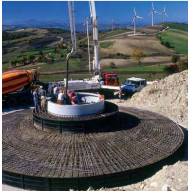
Εικόνα 2.3: Θεμελίωση ανεμογεννήτριας ισχύς 2,3 MW (Αιολικά πάρκα Κρήτης ΕΛΙΚΑ Α.Ε.).
