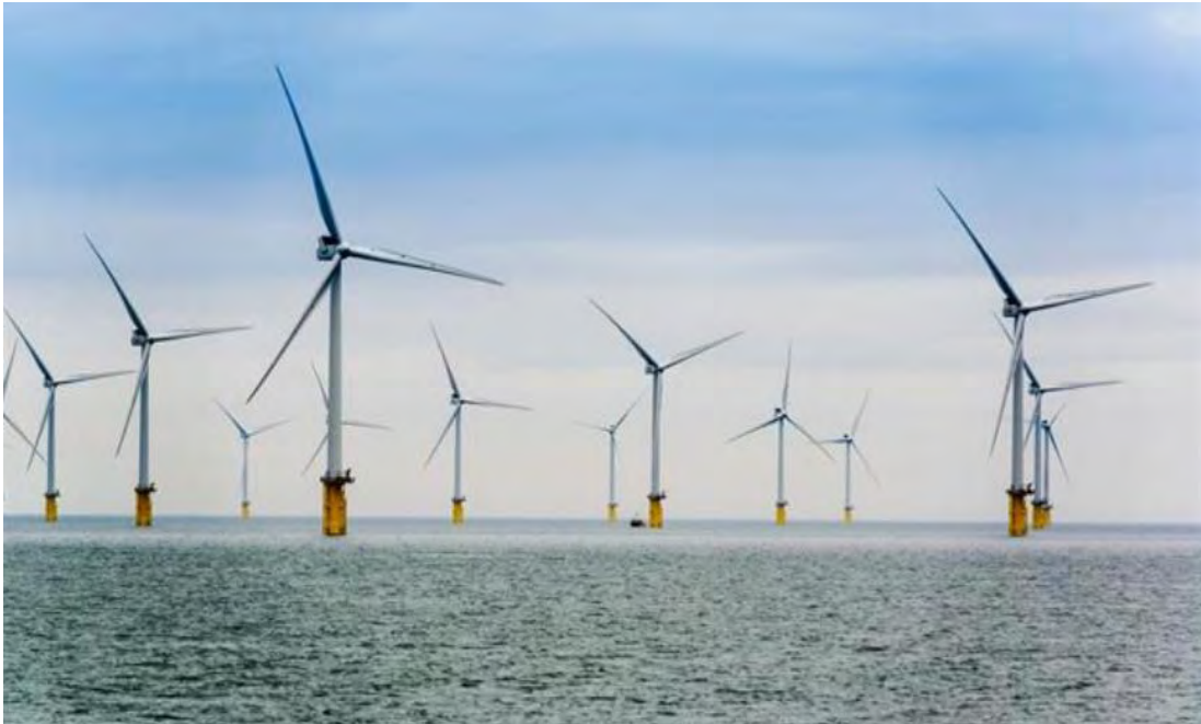
Σχήμα 2.7: Υπεράκτιο αιολικό πάρκο Hornsea 1 (Orsted).
