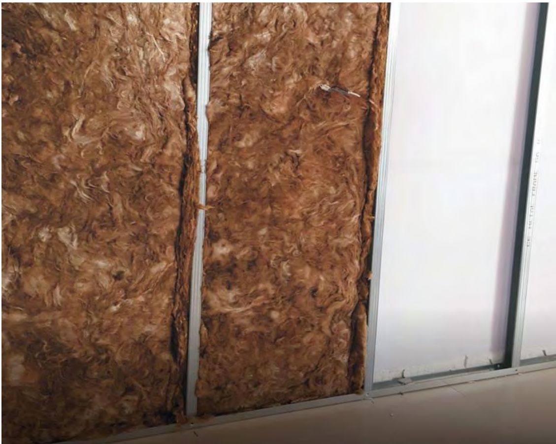
Εικόνα 5.2: Εσωτερική θερμομόνωση με τη χρήση ορυκτοβάμβακα (Πηγή: Goumas, 2020)
