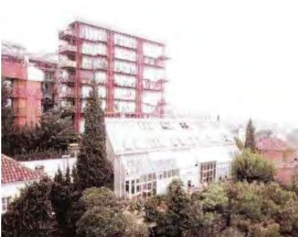
Εικόνα 4.5: Βιοκλιματικό συγκρότημα κατοικιών στη Βαρκελώνη (Πηγή: Ανέμου, 2014)
