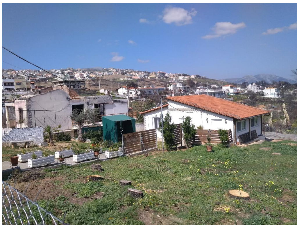
Εικόνα 20: Καμένες και ανέπαφες κατοικίες από φωτιά στο Μάτι
