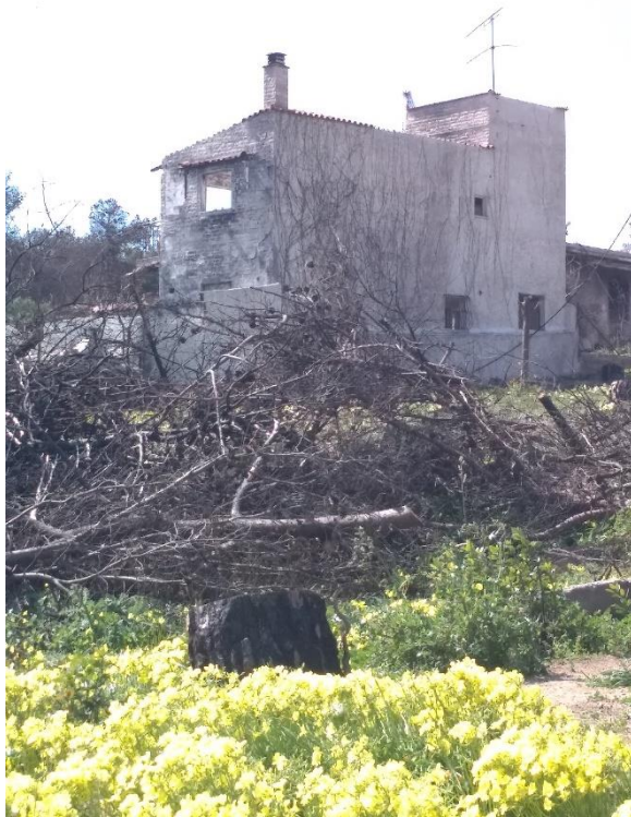
Εικόνα 17: Καμένη κατοικία στο Μάτι
