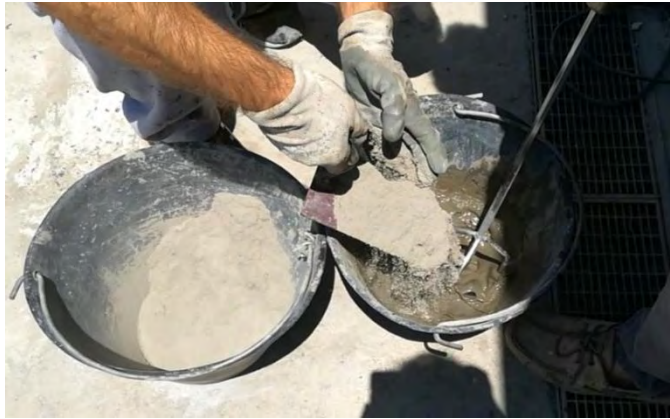
Σχήμα 3-12. Παρασκευή κονιάματος για την περίσφιγξη.
