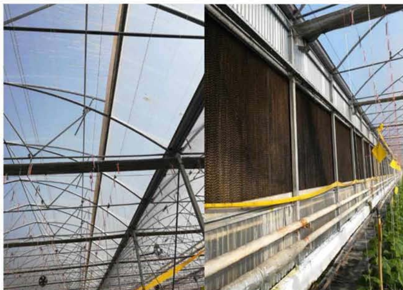
Εικόνα 14. Παράθυρα οροφής (αριστερά) και σύστημα υγρής παρειάς (δεξιά) στη δυτική πλευρά.
