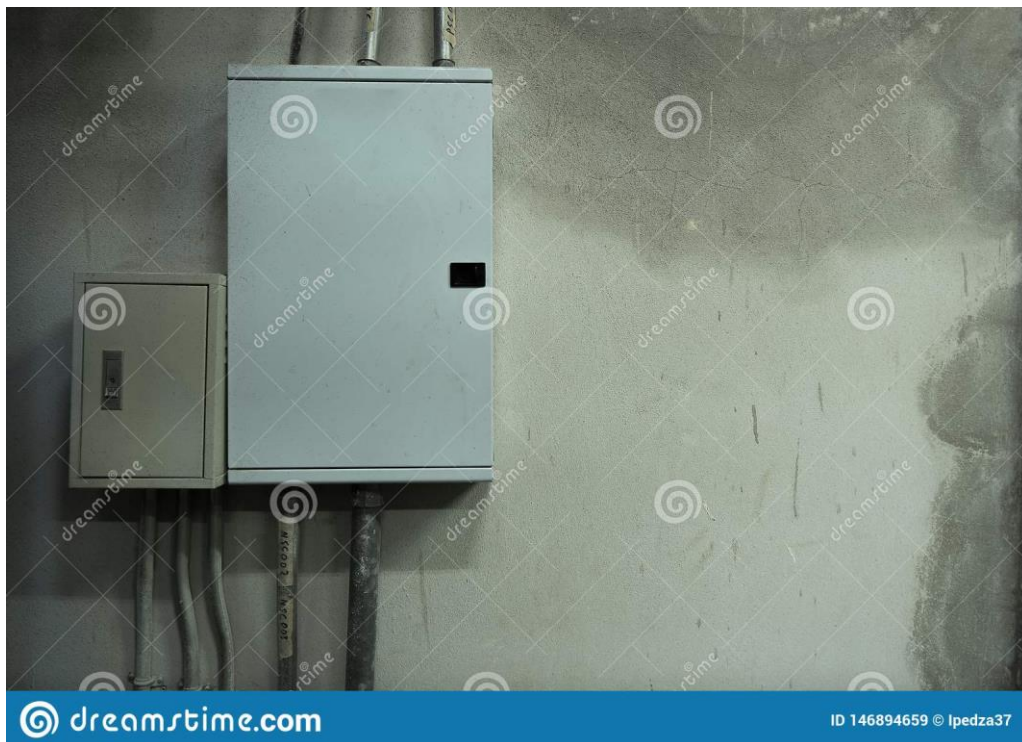
Figure 26: Ηλεκτρικοί πίνακες κυκλωμάτων θαλάμου-ελέγχου στις βιομηχανικές μονάδες.
