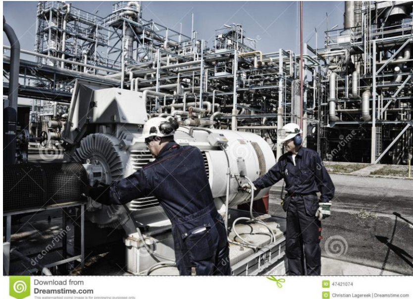
FIGURE 12 ΕΡΓΑΖΟΜΕΝΟΙ ΕΓΚΑΤΑΣΤΑΣΕΩΝ ΚΑΘΑΡΙΣΜΟΥ ΜΕΣΑ ΣΤΟ ΠΕΤΡΕΛΑΙΟ.
