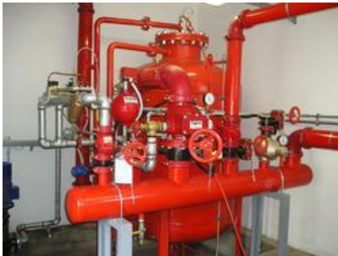
Figure 31: ΕΓΚΑΤΑΣΤΑΣΗ ΕΞΟΠΛΙΣΜΟΥ ΠΥΡΟΣΒΕΣΗΣ
