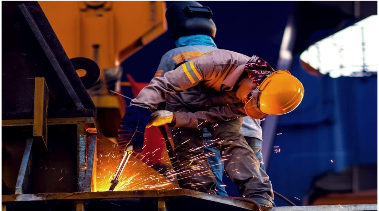
FIGURE 13 ΕΡΓΑΖΟΜΕΝΟΣ, ΠΡΟΣΤΑΤΕΥΜΕΝΟΣ ΚΑΤΑ ΤΗΝ ΕΚΤΕΛΕΣΗ ΤΗΣ ΕΡΓΑΣΙΑΣ ΤΟΥ ΣΕ ΒΙΟΜΗΧΑΝΙΚΗ ΜΟΝΑΔΑ.
