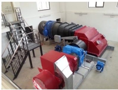
Εικόνα 7: Στρόβιλοι τύπου CrossFlow
