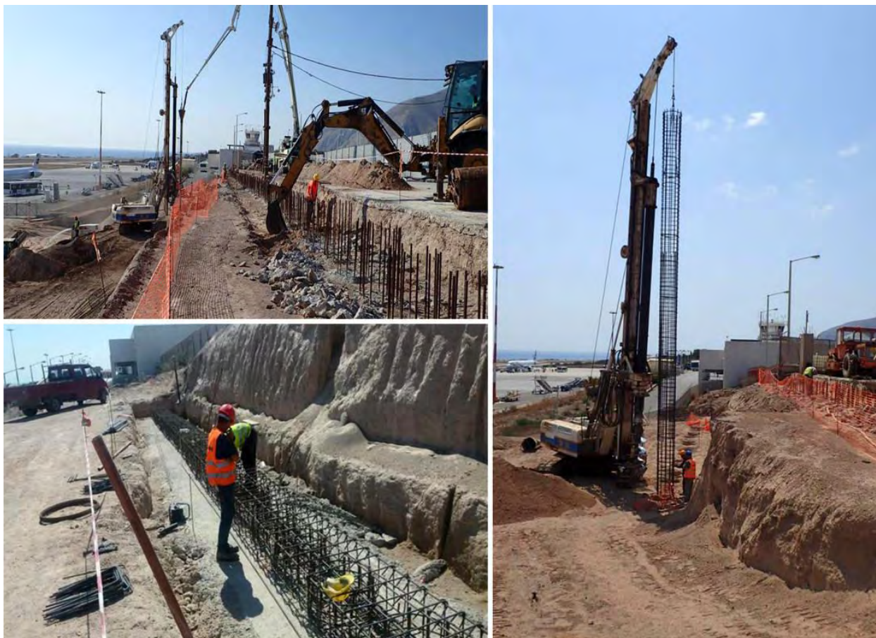
Σχήμα 19 : Το Πριν και το Μετά του Αεροδρομίου της Σαντορίνης Πηγή: Η εξέλιξη και τα έργα στα 14 περιφερειακά αεροδρόμια, 2019
