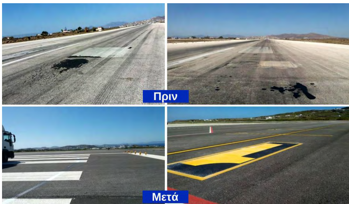
Σχήμα 15 : Το Πριν και το Μετά του Αεροδρομίου της Μυκόνου Πηγή: Η εξέλιξη και τα έργα στα 14 περιφερειακά αεροδρόμια, 2019
