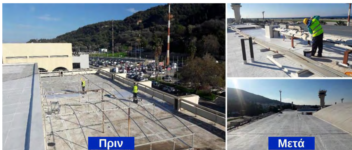
Σχήμα 21 : Το Πριν και το Μετά του Αεροδρομίου της Ρόδου Πηγή: Η εξέλιξη και τα έργα στα 14 περιφερειακά αεροδρόμια, 2019
