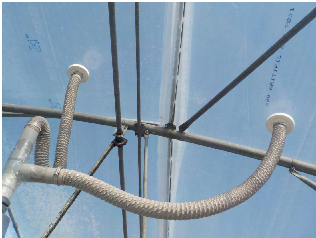
Εικόνα 2.6: Μηχανισμός διοχέτευσης αέρα μεταξύ των δύο 3 - στρωματικών φύλλων από τα οποία αποτελείται το νέου τύπου 7 - στρωματικό φύλλο κάλυψης
