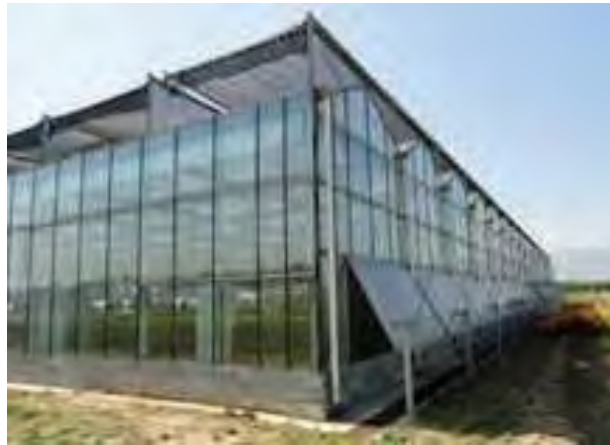
Εικόνα 7: Τοποθέτηση εξωτερικών δίκτυα στην οροφή θερμοκηπίου για την μείωση της εισερχόμενης ηλιακής ακτινοβολίας.
