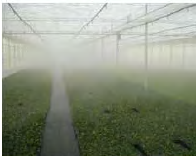
Εικόνα 4: Ψύξη με εξάτμιση με την χρήση συστήματος τεχνητής ομίχλης ψεκασμού σταγονιδίων νερού(Katsoulas et al. , 2006).
