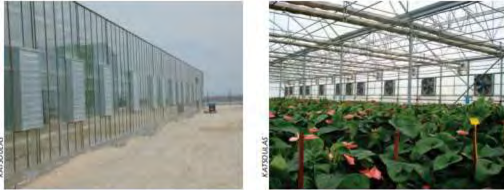
Εικόνα 3: Χρήση μηχανικού αερισμού σε θερμοκήπιο. Εξαγωγή εσωτερικού αέρα (αριστερά) και εισαγωγή εξωτερικού αέρα στο θερμοκήπιο (δεξιά) (Katsoulas et al. , 2006).
