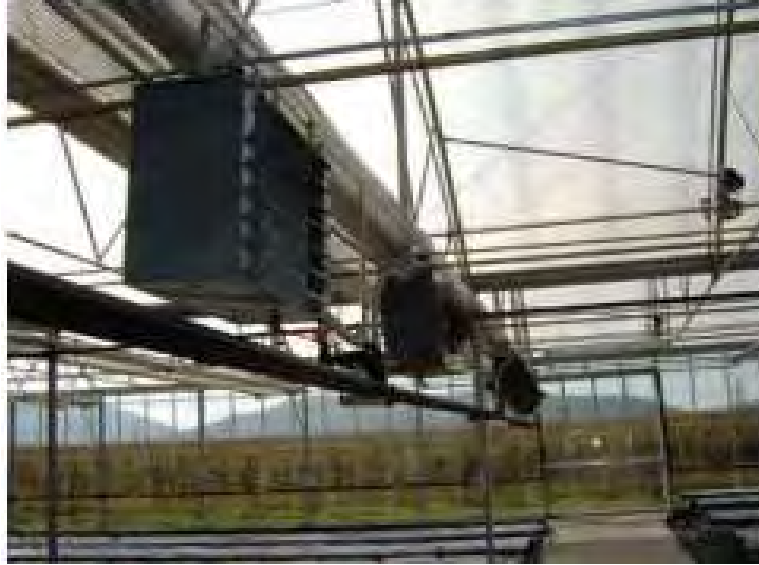
Εικόνα 6: Απεικόνιση των θερμαντήρων αέρα που έχουν τοποθετηθεί στο εσωτερικό θερμοκηπίου (Katsoulas et al. , 2006).
