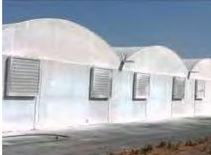
Εικόνα 9: Σκίαση θερμοκηπίου με την μέθοδο εξωτερικής βαφής του υλικού κάλυψης του θερμοκηπίου (FAO 2017).
