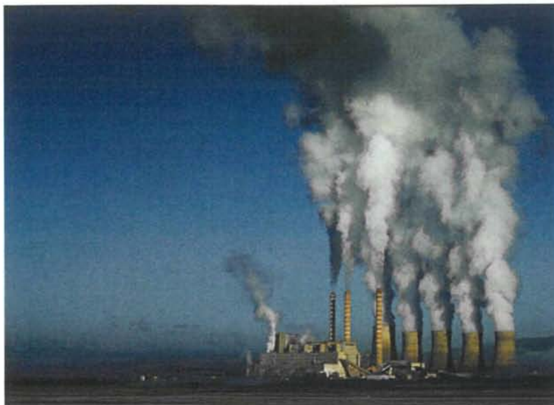
Εικόνα 1.1: Ατμοηλεκτρικός σταθμός Πτολεμαΐδας
