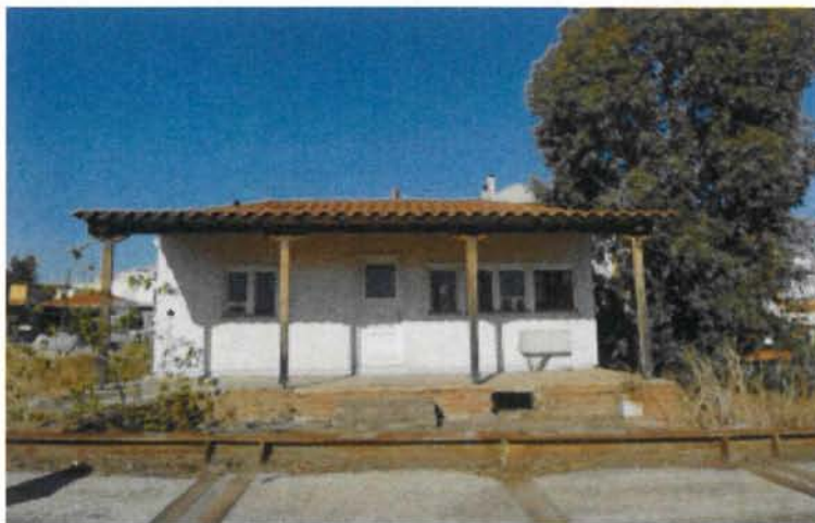
Εικόνα 6.6: Ο σταθμός μέτρησης ατμοσφαιρικής ρύπανσης (ΣΜΑΡ) του ΟΛΒ
