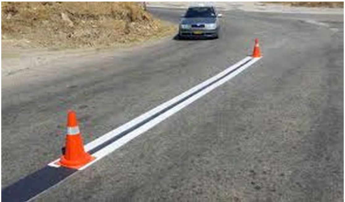
Εικόνα 3.11: Καινούρια διαγράμμιση πάνω από φθαρμένη
