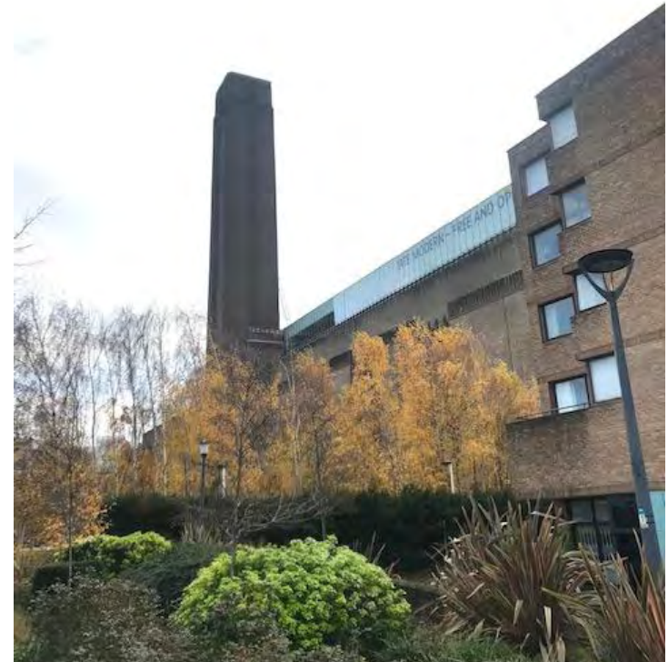
Εικόνα 9: Εξωτερική άποψη του κτιρίου, πηγή: Προσωπικό φωτογραφικό αρχείο
