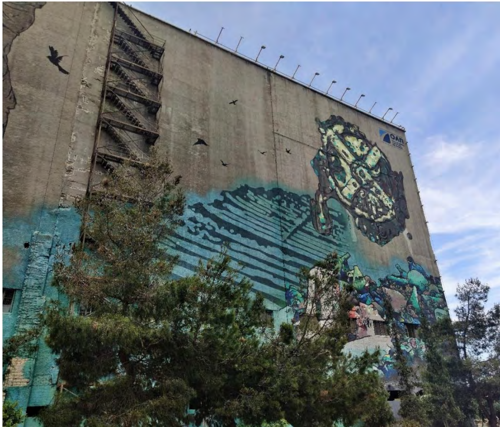
Εικόνα 6.3.5.: Βόρεια Όψη SILO
