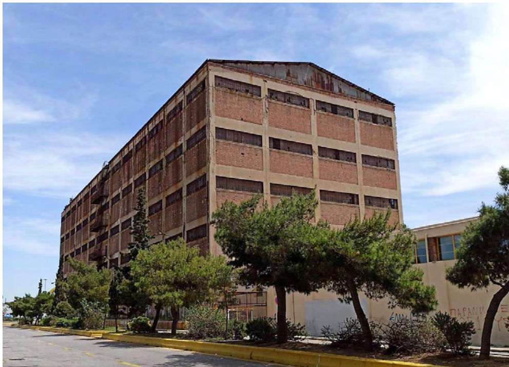
Εικόνα 6.3.6.: Αποθήκη στην ανατολική πλευρά του SILO
