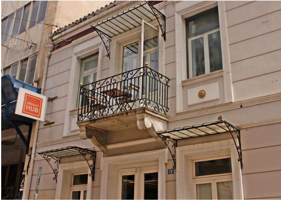
Το νεοκλασικό κτίριο που στεγάζει το Impact Hub Athens. Πηγή: Google Maps.
