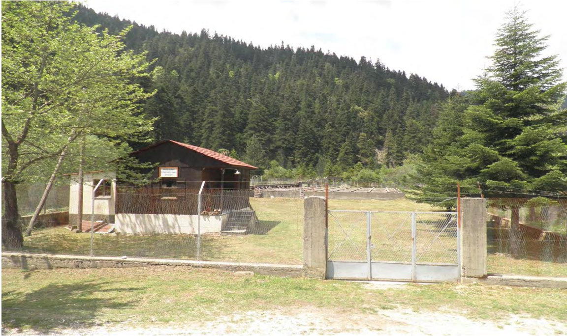
Εικόνα 3: Οι εγκαταστάσεις του πεστροφογεννητικού σταθμού Ασπροποτάμου στη Θέση «Κουκουφλί»
