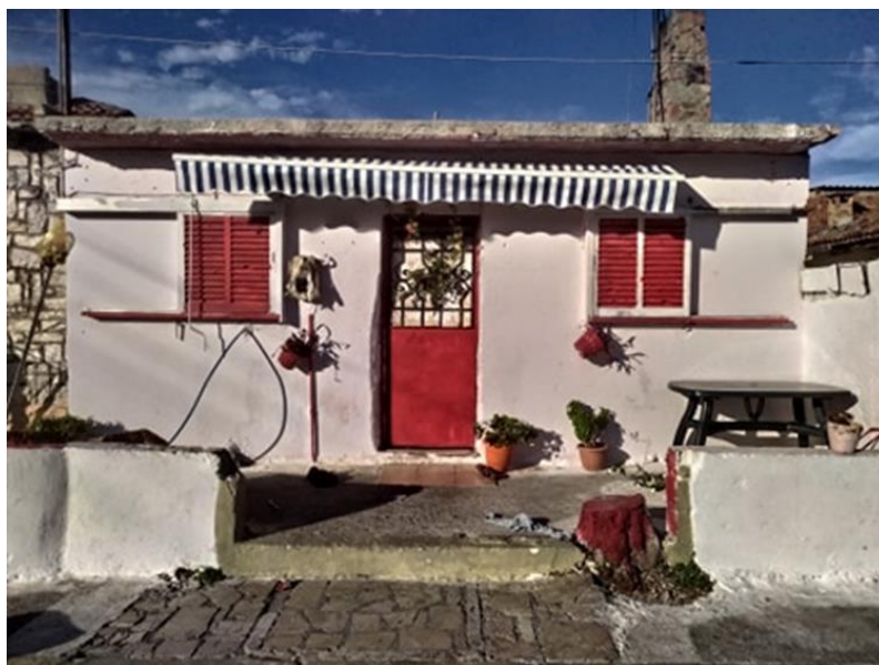
Εικόνα 7.13: Κατοικία σε μέτρια κτηριακή κατάσταση
