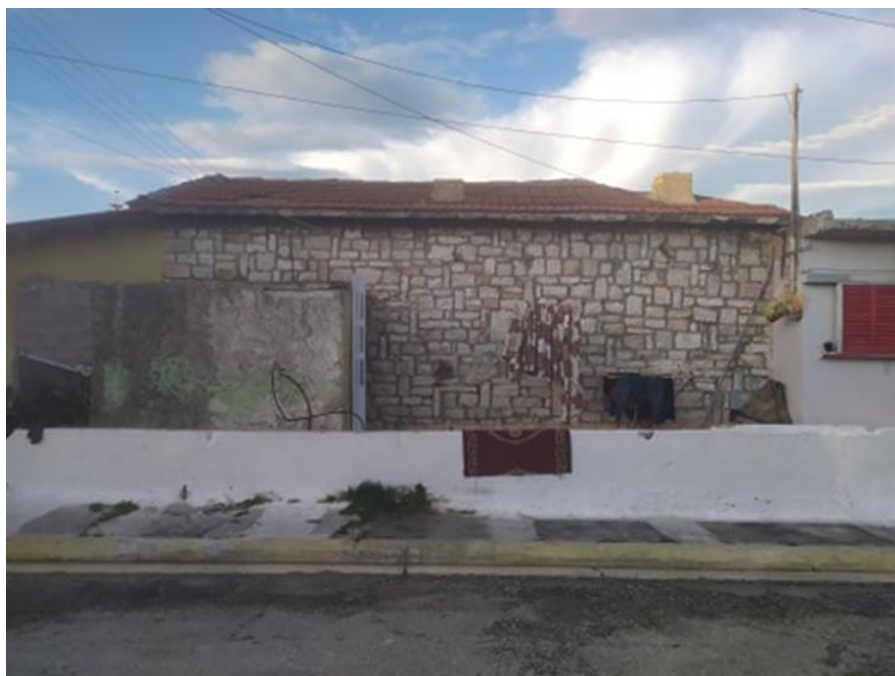
Εικόνα 7.26: Τουαλέτα εξωτερικά της κατοικίας
