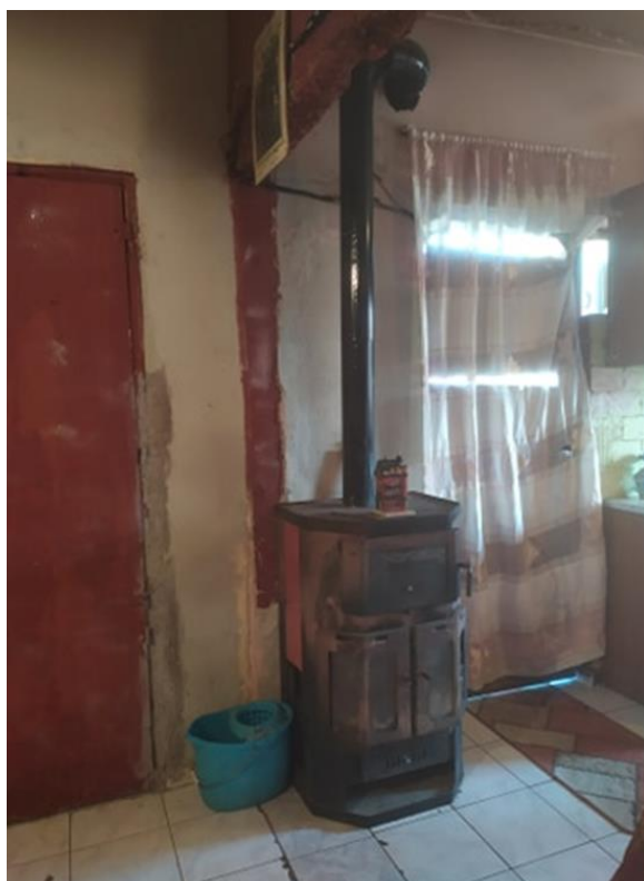
Εικόνα 7.23: Εξοπλισμός θέρμανσης κατοικίας
