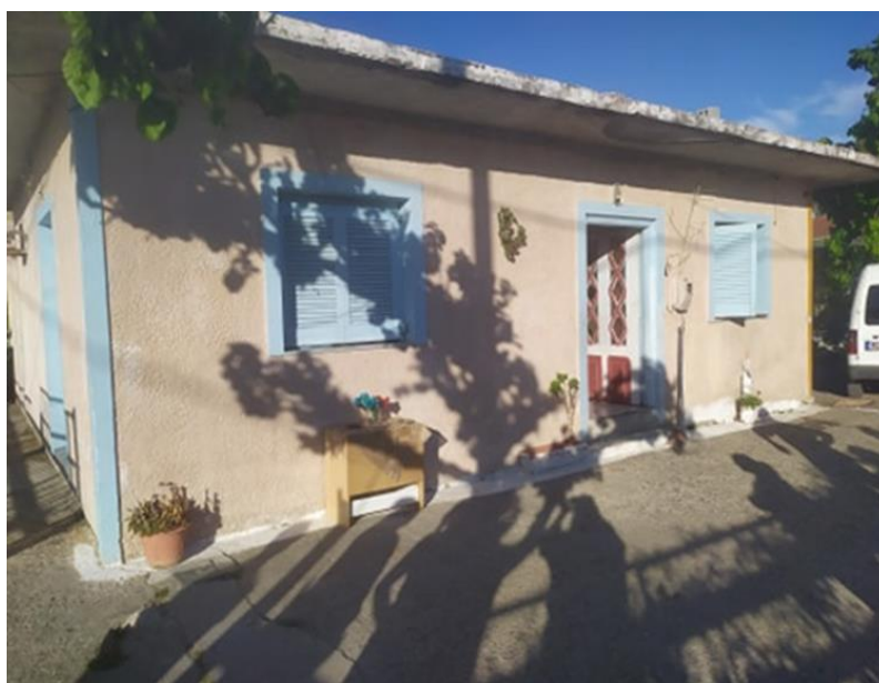
Εικόνα 7.14: Κατοικία σε μέτρια κτηριακή κατάσταση
