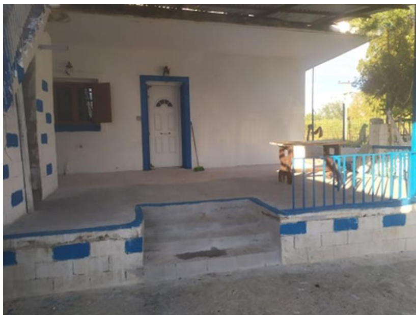
Εικόνα 7.12: Κατοικία σε καλή κτηριακή κατάσταση
