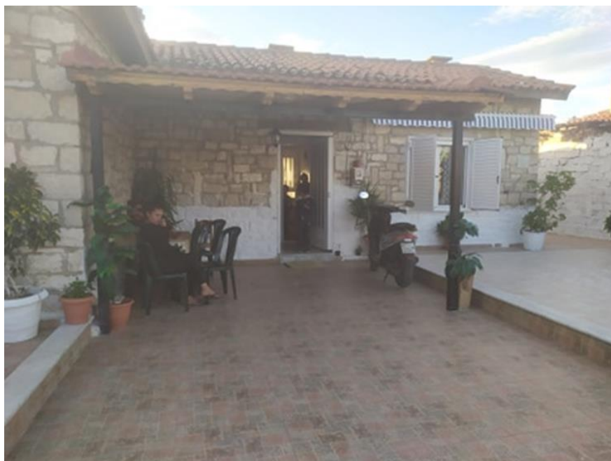
Εικόνα 7.11: Κατοικία σε καλή κτηριακή κατάσταση
