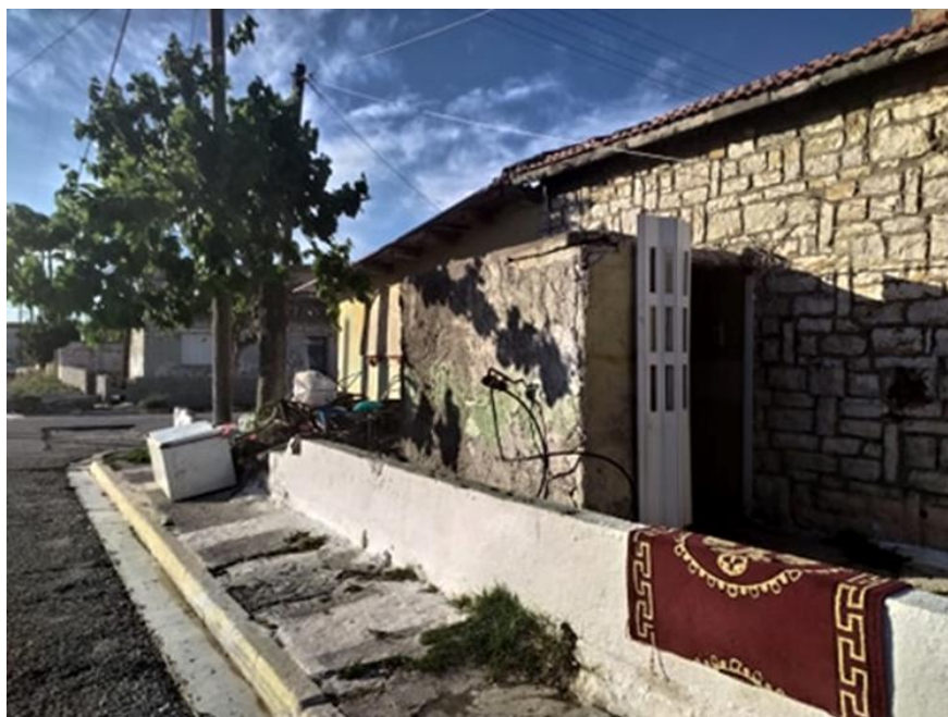
Εικόνα 7.25: Τουαλέτα εξωτερικά της κατοικίας
