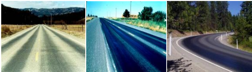
Εξίδρωση στα ίχνη των τροχών
