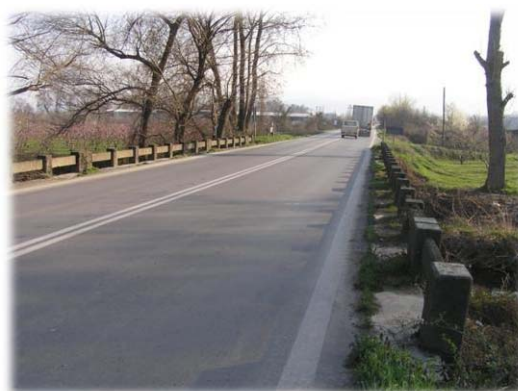
Φωτογραφία 8.5β: Στενή λωρίδα/ ανύπαρκτο έρεισμα σε παλαιά γέφυρα
