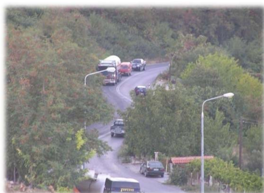
Φωτογραφία 8.5α: Μη αποδεκτό πλάτος λωρίδας – κακός γεωμετρικός σχεδιασμός
