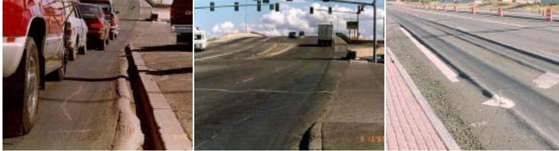
Τροχοαυλάκωση ασφαλτομίγματος
