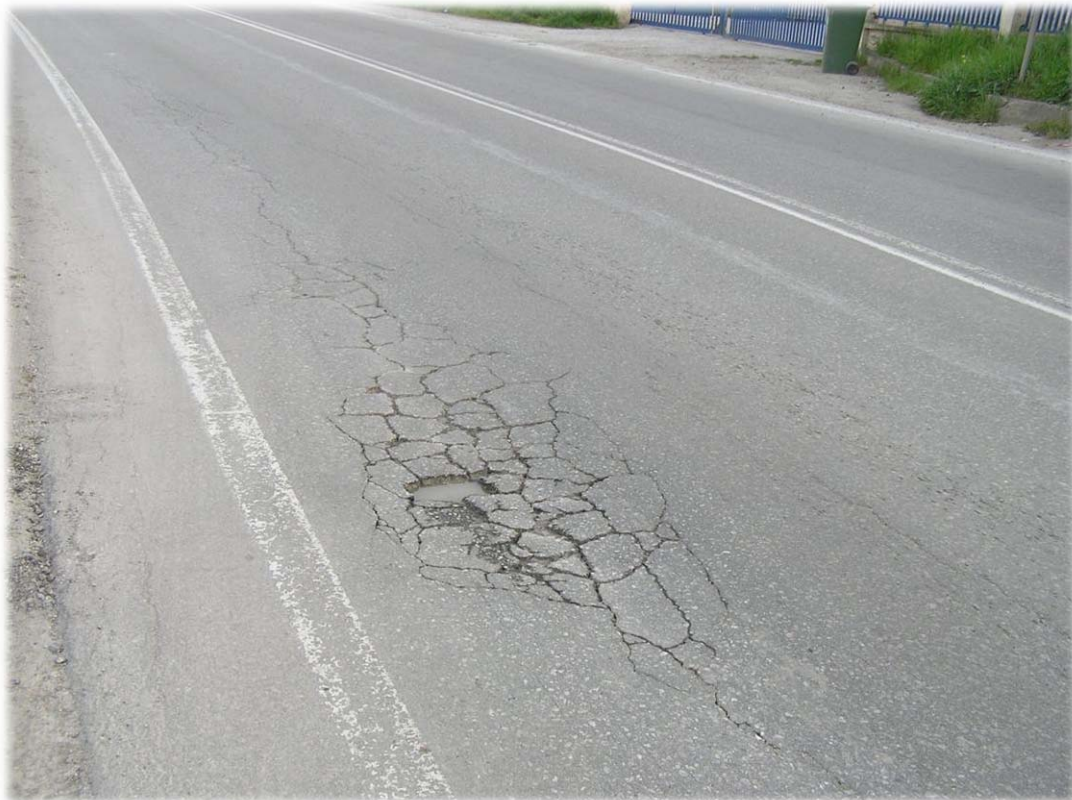
Φωτογραφία 8.6: Φθορές επιφανείας οδοστρώματος – Τροχοαυλάκωση, ρηγματώσεις και λακκούβες
