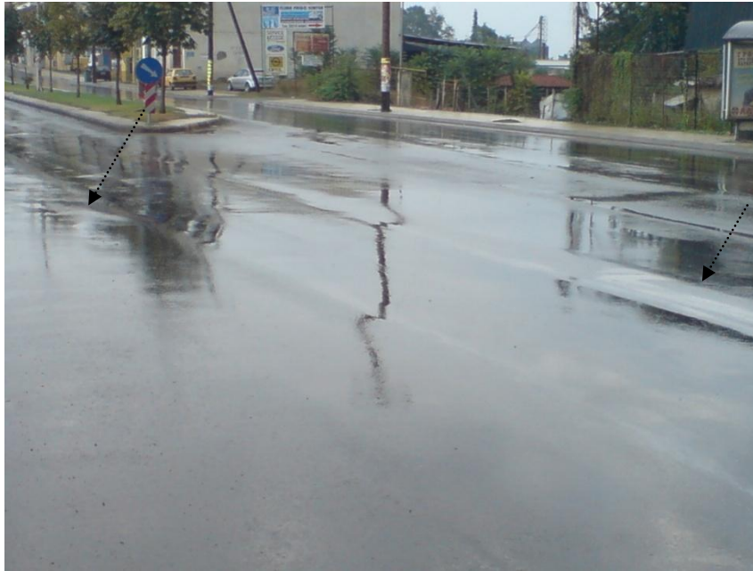
Σχήμα 6.8: Έντονη τροχοαυλάκωση και μη αποδεκτή επιπεδότητα / Ικανοποιητικές τιμές αντίστασης ολίσθησης
