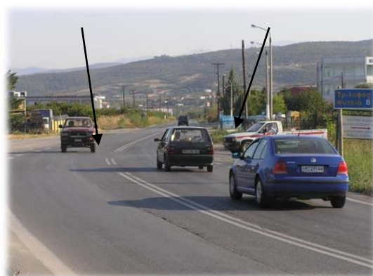
Φωτογραφία 8.3β: Ανεπαρκής κόμβος – ανυπαρξία λωρίδας αριστερής στροφής
