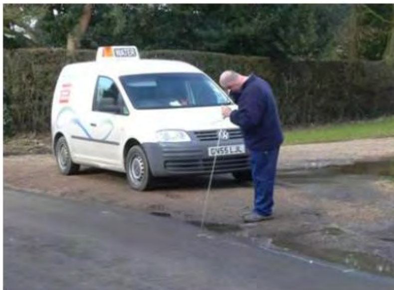
Εικόνα 5.2 Τεχνικός διαρροών πραγματοποιεί ακρόαση με παραδοσιακή ράβδο ακρόασης (Pilcher et al., 2008)
