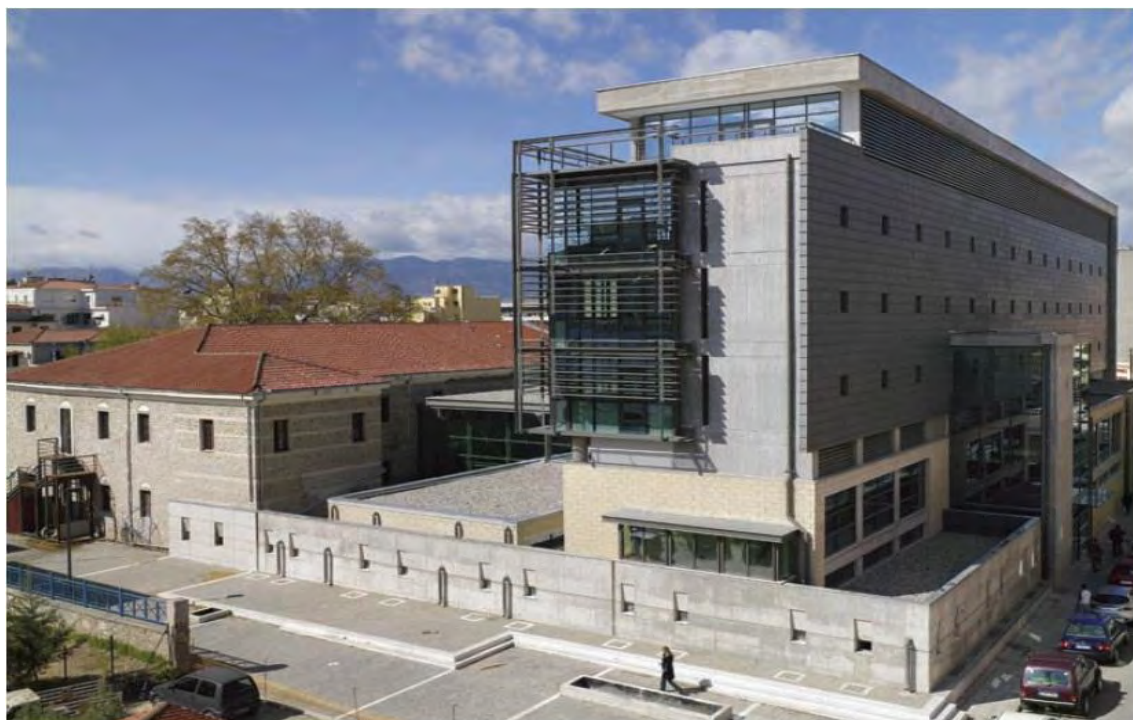
Εικόνα 3.2 Βορειοανατολική άποψη του κτηρίου (Κίζης Γ.)
