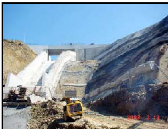
Εικόνες 7 - 6 και 7 - 7: Αστοχία κατά την εκσκαφή του εκχειλιστή και τελικά μέτρα προστασίας (Πηγή: Θανόπουλος Ι., 2006)
