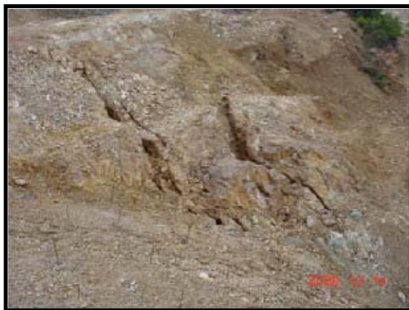
Εικόνες 7 - 6 και 7 - 7: Αστοχία κατά την εκσκαφή του εκχειλιστή και τελικά μέτρα προστασίας (Πηγή: Θανόπουλος Ι., 2006)
