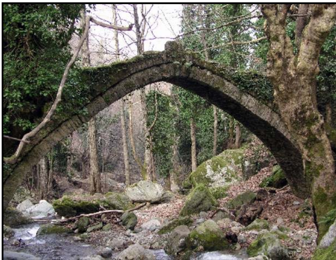
Εικόνα 9 – 9: Το γεφύρι της Ταράτσας ή Μαλαμάκη πριν βυθιστεί στον πυθμένα του ταμιευτήρα (Χαράτσης, 1996)
