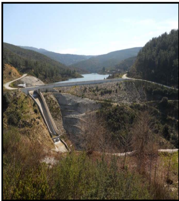
Εικόνα 7 – 2: Άποψη του υπερχειλιστή του φράγματος
