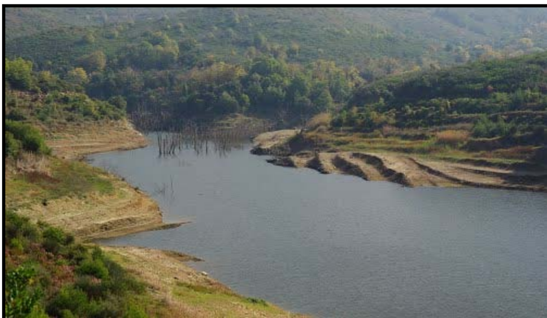
Εικόνα 9 – 3: Ερπυστικά φαινόμενα κατά την πλήρωση του ταμιευτήρα (Πηγή: http://www.panoramio.com )
