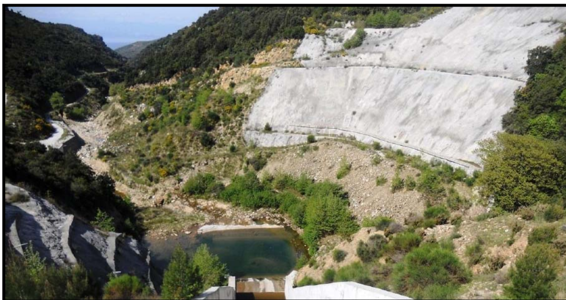
Εικόνα 9 – 8: Αισθητική υποβάθμιση κατάντη του φράγματος στη λεκάνη αποτόνωσης
