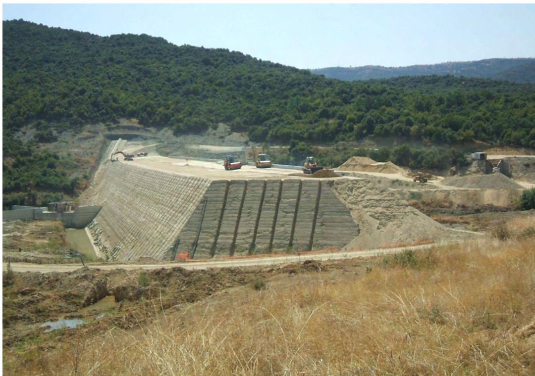
Εικόνα 3.1 Το φράγμα Ληθαίου
