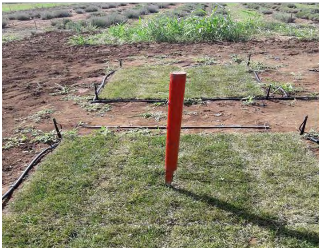
Εικόνα 3.9. Εγκατάσταση αισθητήρα υγρασίας
