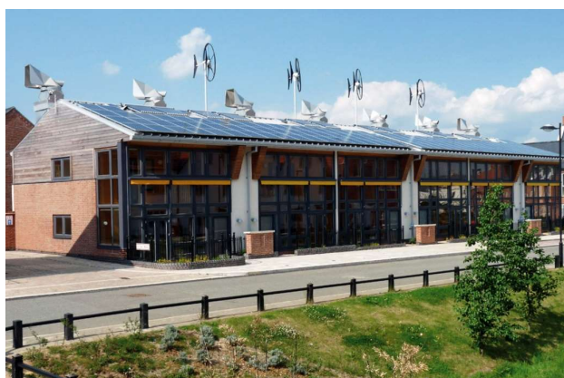
Εικόνα 6.15: Μικρές ανεμογεννήτριες κοντά σε κτίρια
