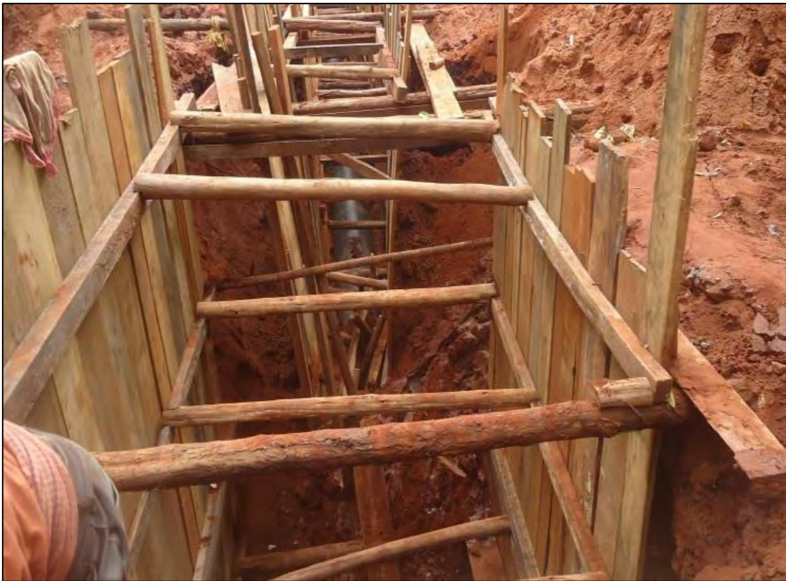
Εικόνα 9: Αντιστηρίξεις ξύλινων πασσαλοσανίδων
