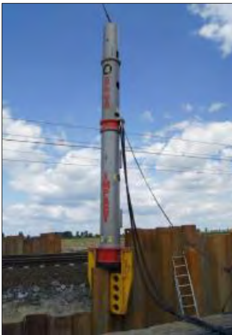
Εικόνα 17: Υδραυλική κρουστική σφύρα έμπηξης μεταλλικών πασσαλοσανίδων, sbh-shoring.com
