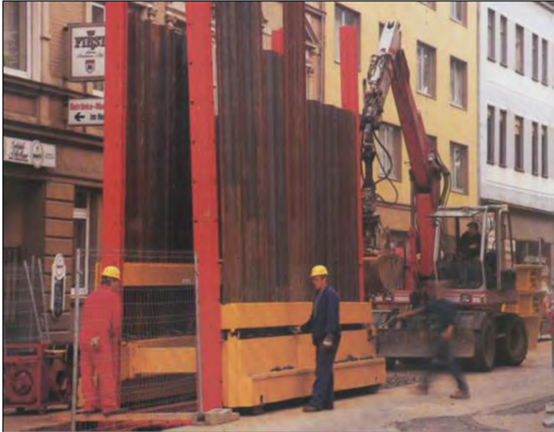
Εικόνα 16: Μεταλλικές πασσαλοσανίδες-πλαίσιο, krings.com/en
