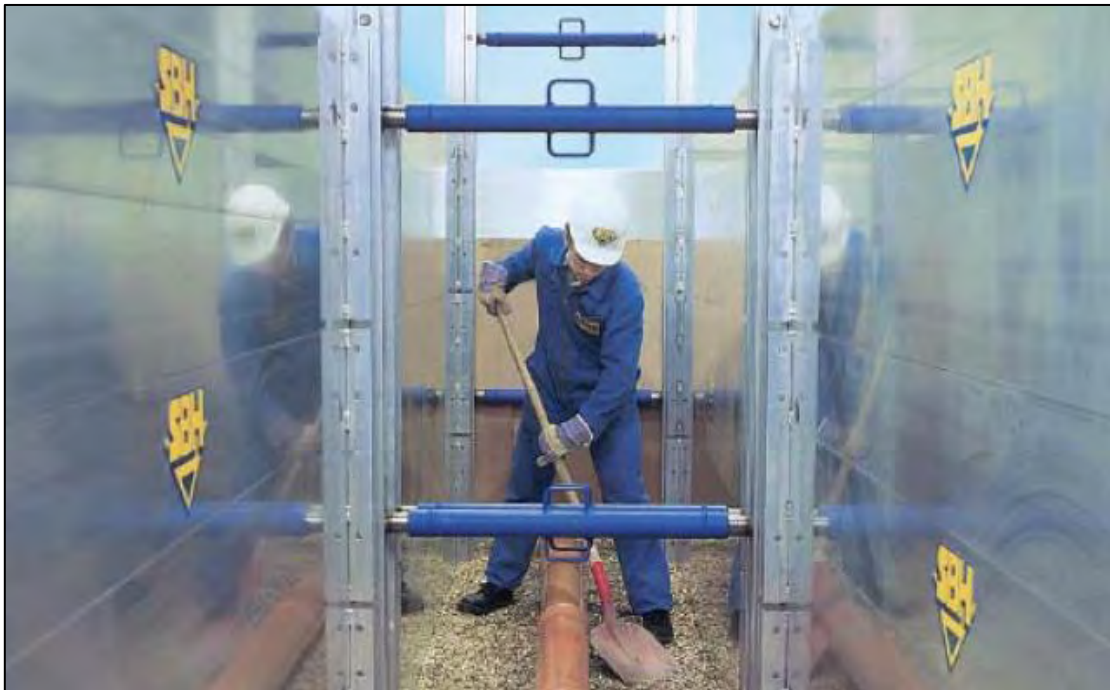
Εικόνα 29: Σύστημα Box, ελαφρού τύπου (αλουμινίου), sbh-shoring.com
