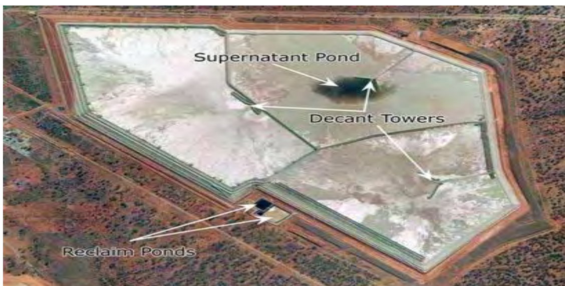
Εικόνα 4.13: Φράγμα τελμάτων σε διάταξη κυκλικού αναχώματος με τρεις κυψέλες, Δυτική Αυστραλία
