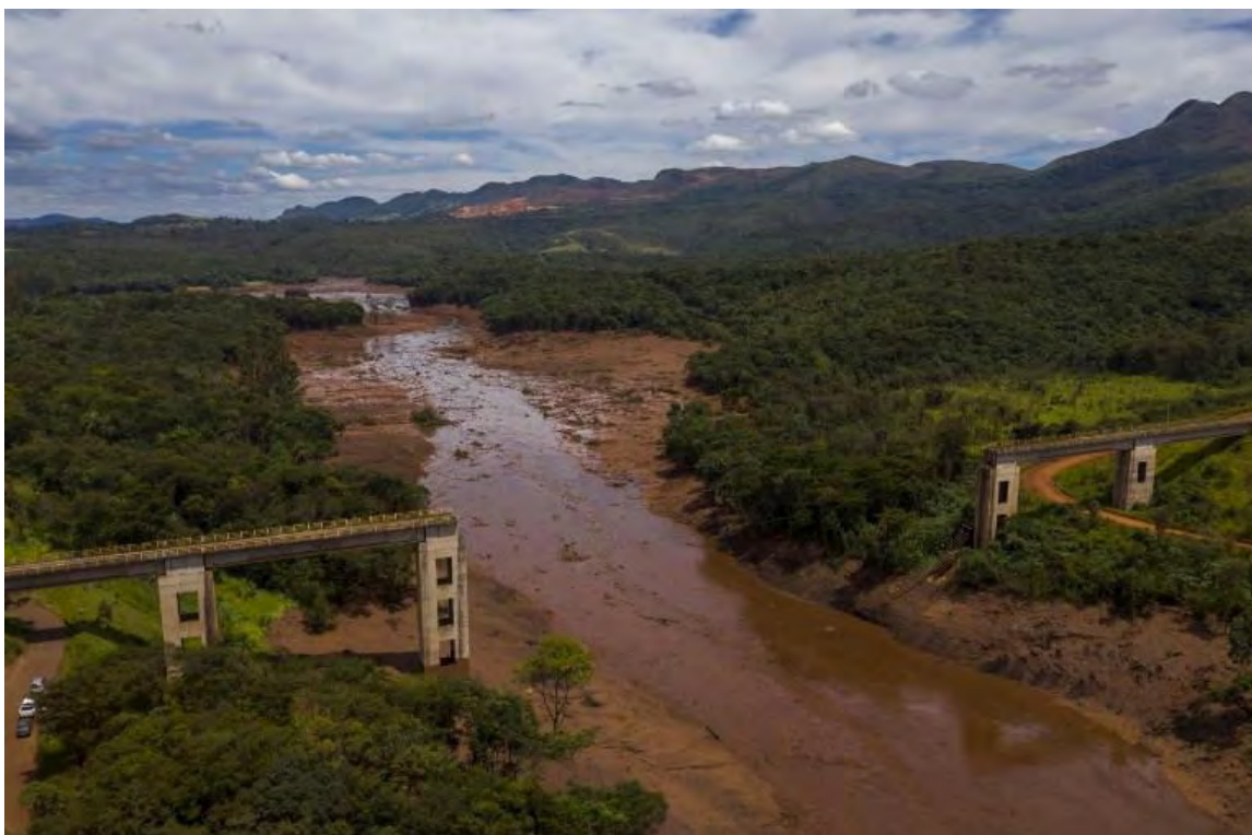
Εικόνα 2.5: Κατάρρευση φράγματος στην περιοχή Brumadinho στη Βραζιλία
