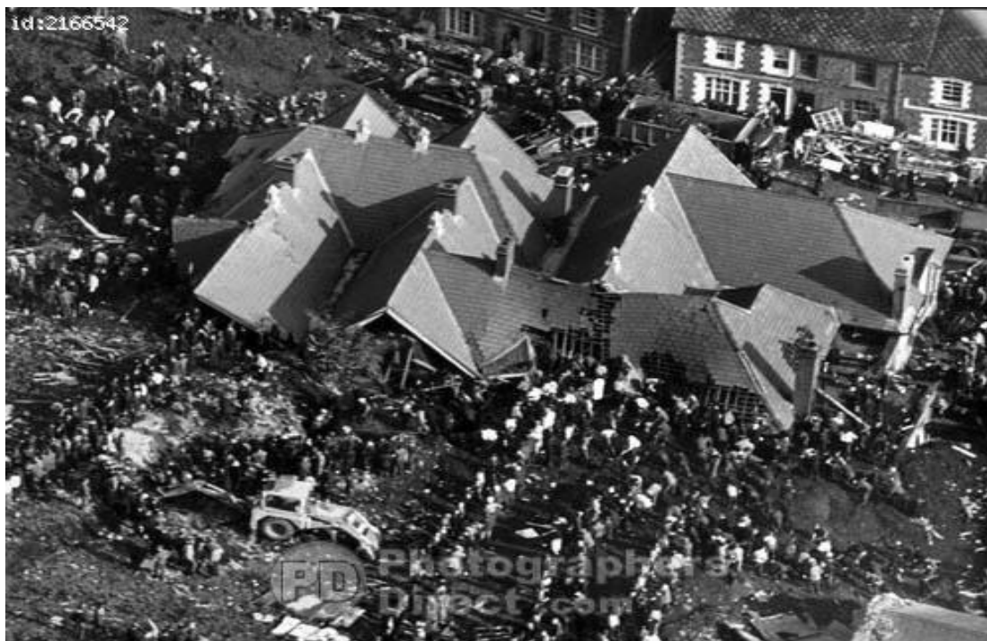
Εικόνα 2.1: Κατάρρευση σωρών στείρων σε δημοτικό σχολείο στο Aberfan
