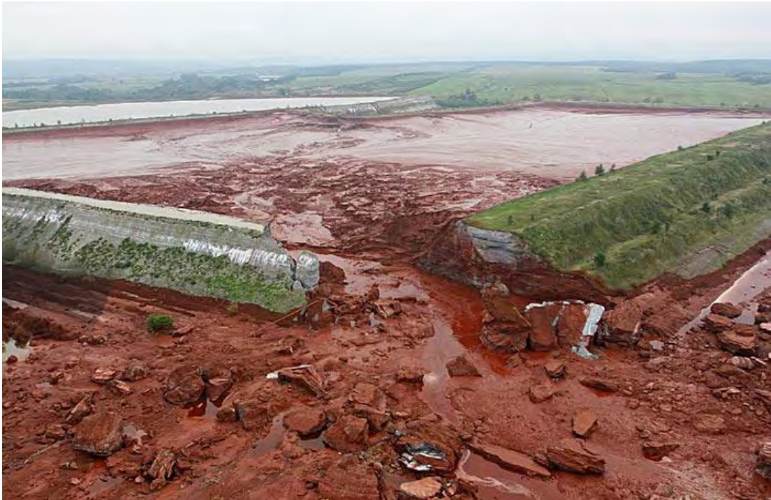
Εικόνα 2.4: Κατάρρευση φράγματος στην περιοχή Ajka στην Ουγγαρία
