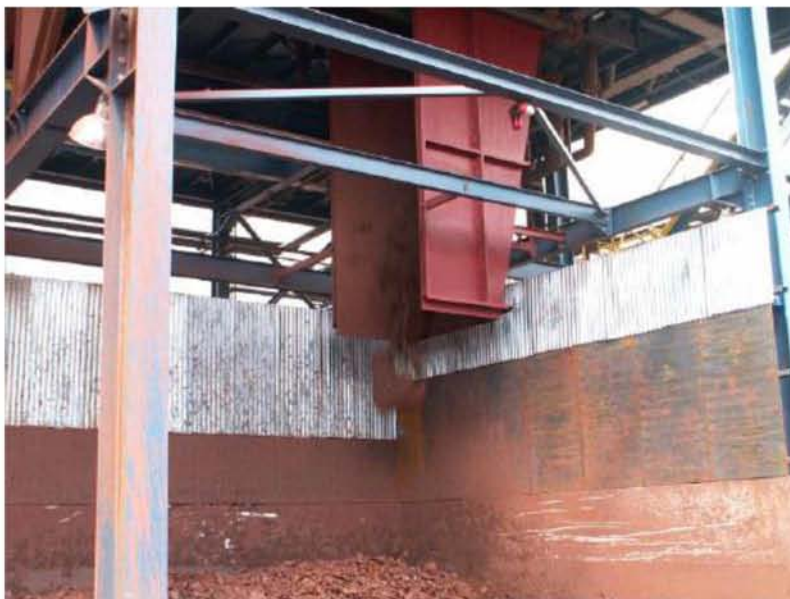
Εικόνα 4.5: Άνοιγμα των πλαισίων και απόρριψη του υλικού, ακριβώς κάτω από την πρέσα
