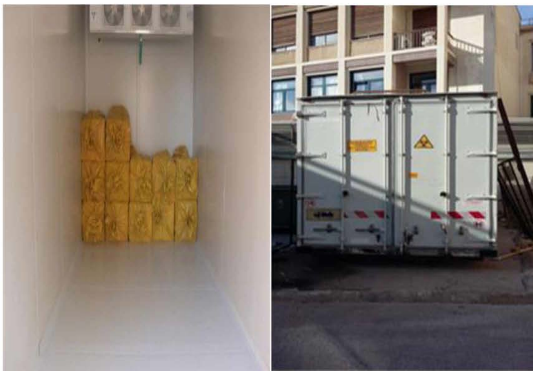
Εικόνα 7: Εσωτερική και εξωτερική εικόνα ψυγείου επικίνδυνων αποβλήτων
