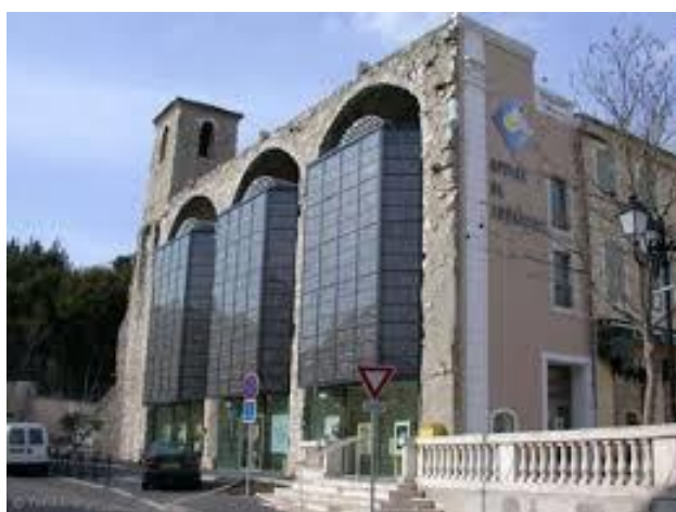
Εικόνα 18: Πρόσοψη διατηρητέου κτιρίου (Πηγή: Σύνδεσμος Εταιριών φωτοβολταϊκών 2019)
