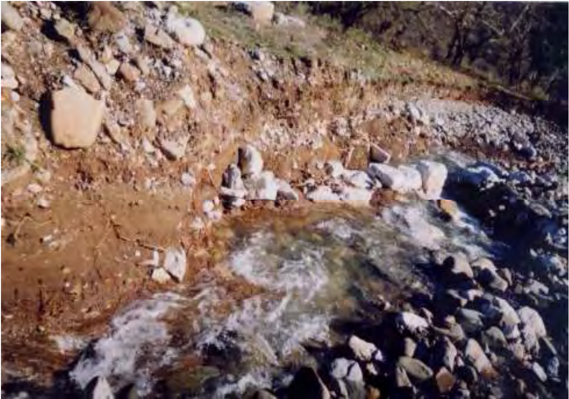
Εικ. 306/167. Άνω Κλειτορία (παλ. τοπων. Καρνέσι) Καλαβρύτων, θέση Κοίτη ποταμού Καρνέσιου. Τοίχος στην αριστερή/νότια όχθη του ποταμού
