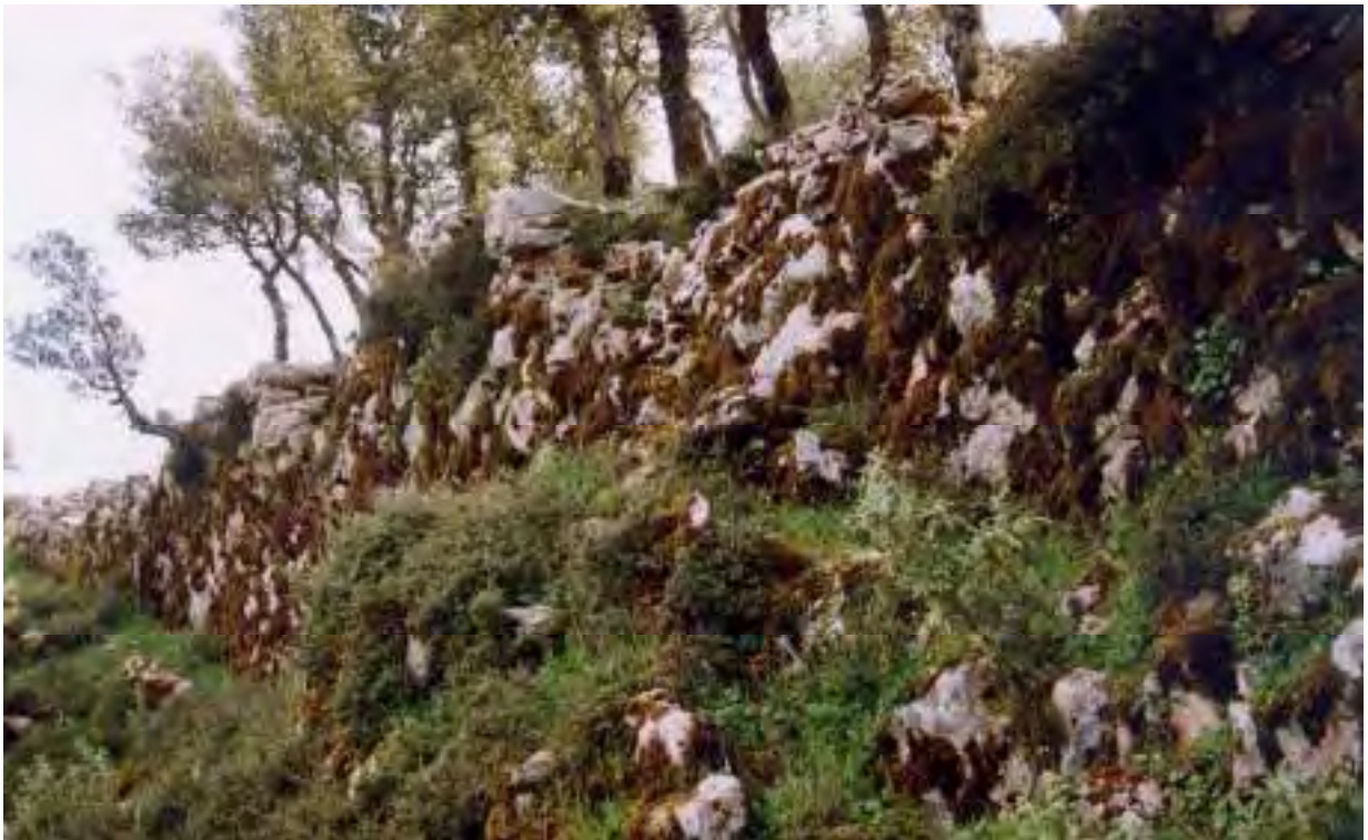
Εικ. 536/299. Πάος (παλ. τοπων. Σκούπι) Καλαβρύτων, θέση Σκουπίτσι, ή Σκουπίτσα. Άποψη της Β/ΒΔ πλευράς του τείχους, από ΝΔ
