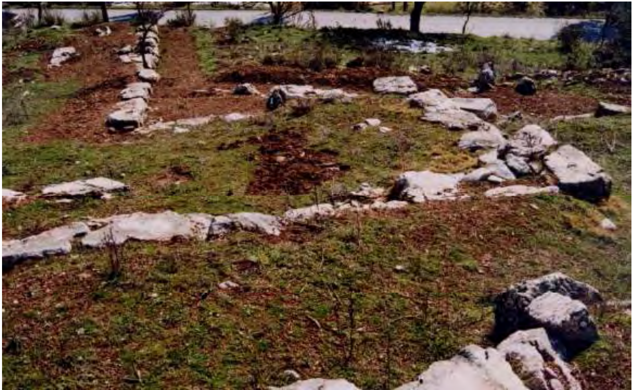
Εικ. 489/261. Οικισμός Κάτω Τριπόταμα Τριποτάμων Καλαβρύτων, θέση Παλιομονάστηρο, ή Μοναστήρια. Πύλη και πύργος στη ΝΔ πλευρά του τείχους, από Β
