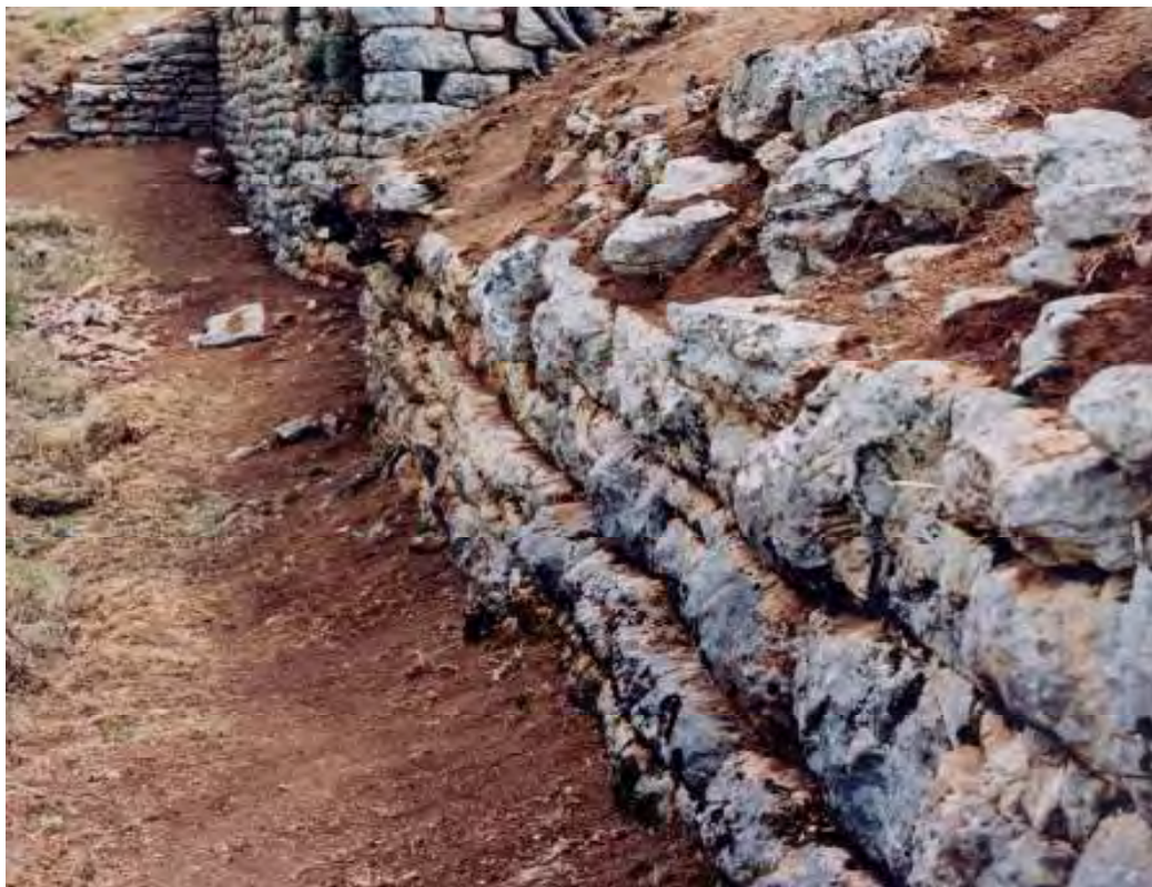
Εικ. 465/254. Οικισμός Κάτω Τριπόταμα Τριποτάμων Καλαβρύτων, θέση Βρύση του Κατριβά. Μερική άποψη του τείχους της δυτικής πλευράς (βόρειο πέρας), μετά τον καθαρισμό, από ΝΔ
