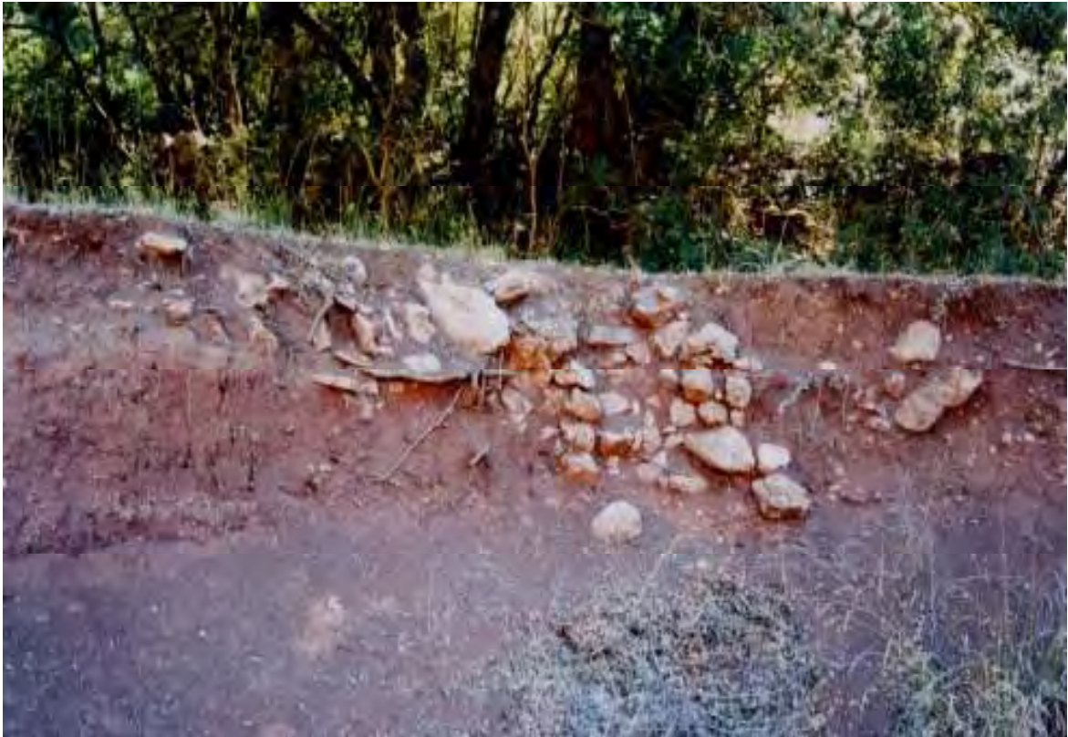
Εικ. 356/206. Λυκουρία [=Λυκούρι, Λυκούρια] Καλαβρύτων, θέση Κάτω Νίστα. Τμήμα τοίχου στην παρειά του ορύγματος
