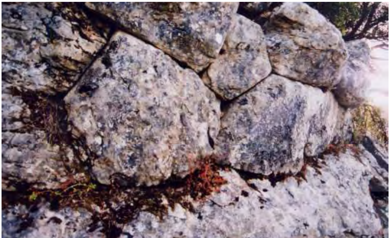
Εικ. 514/282. Αμυγδαλέα (παλ. τοπων. Μαμαλούκα) Καλαβρύτων, θέση Βορός. Μερική άποψη της βόρειας πλευράς του οχυρού, θεμελιωμένης στο φυσικό βράχο, από ΒΑ (λεπτομέρεια)
