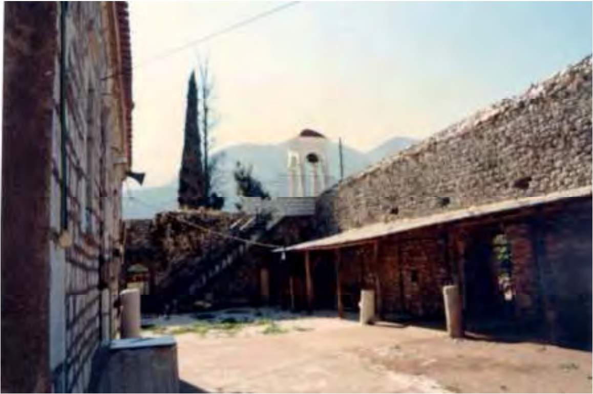
Εικ. 433/252. Οικισμός Κάτω Τριπόταμα Τριποτάμων Καλαβρύτων, θέση Μονή Τριποτάμων, ή Κοιμήσεως Θεοτόκου. Αρχιτεκτονικά μέλη στο εσωτερικό του περιβόλου της Μονής
