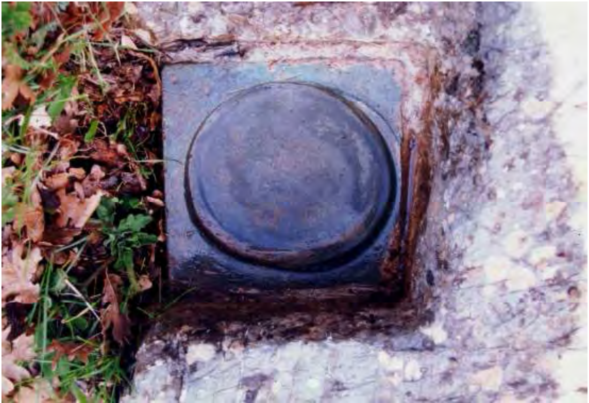
Εικ. 319/181. Άνω Κλειτορία (παλ. τοπων. Καρνέσι) Καλαβρύτων, θέση Παλάτι, ή Καταρράχη. Επιχάλκωμένος όλμος των στροφέων της θύρας
