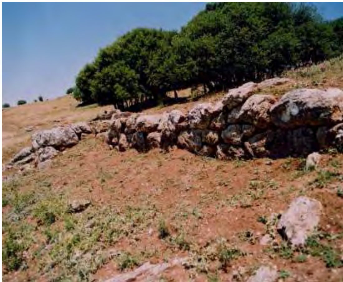
Εικ. 584. Άποψη μεσοπυργίου διαστήματος της Ν πλευράς και ο πύργος 25, από ΝΑ
