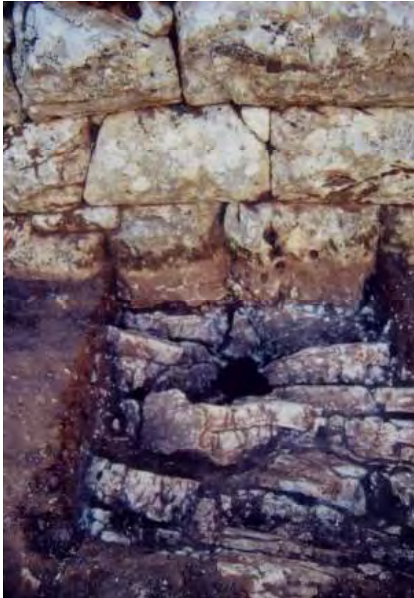
Εικ. 483/261. Οικισμός Κάτω Τριπόταμα Τριποτάμων Καλαβρύτων, θέση Παλιομονάστηρο, ή Μοναστήρια. Έδραση του τείχους της ΝΔ πλευράς στο φυσικό βράχο (εξωτερικό μέτωπο)
