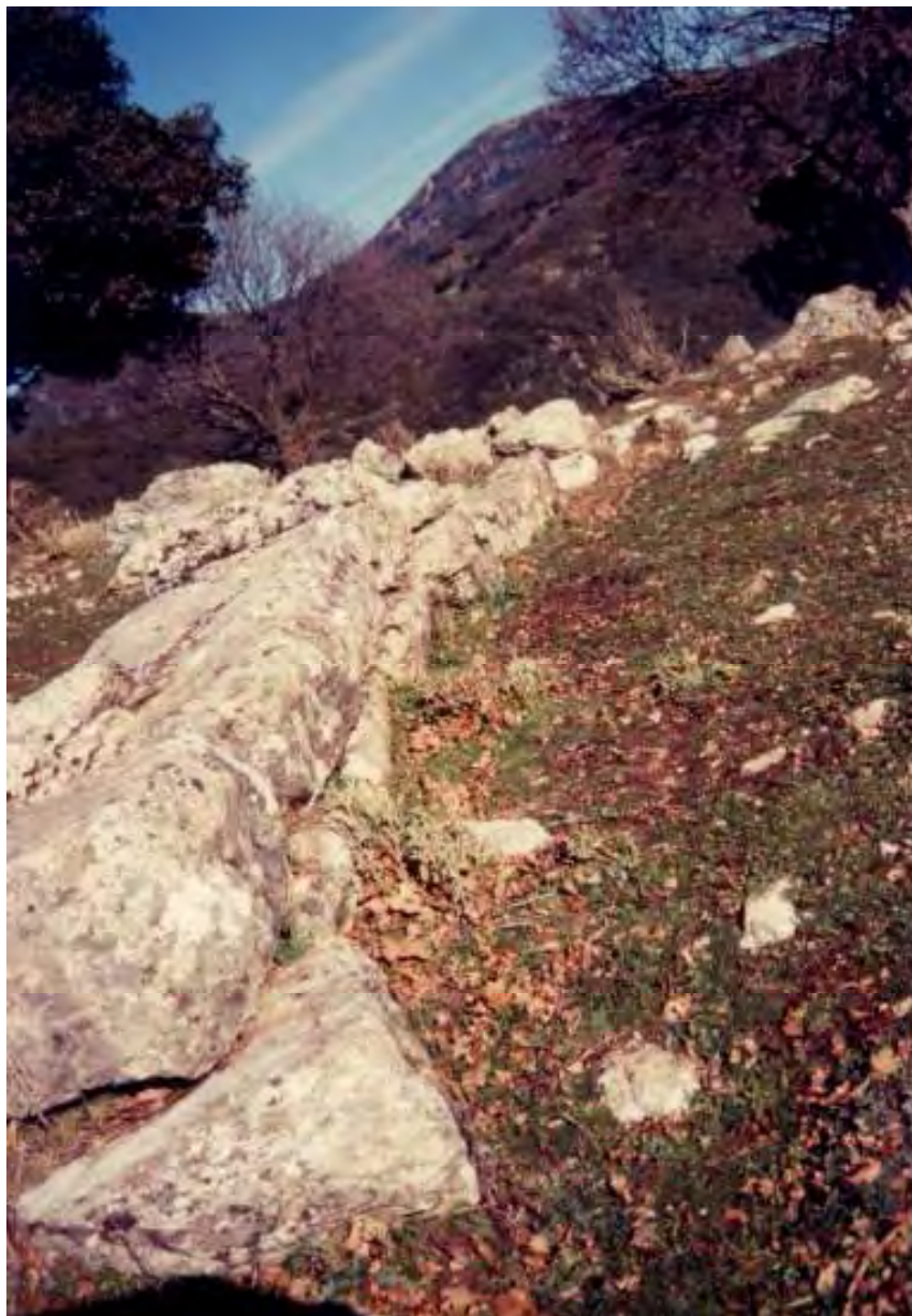
Εικ. 605. Τμήμα αναλημματικού τοίχου στα Α πρανή της κορυφής του λόφου, από ΝΑ
