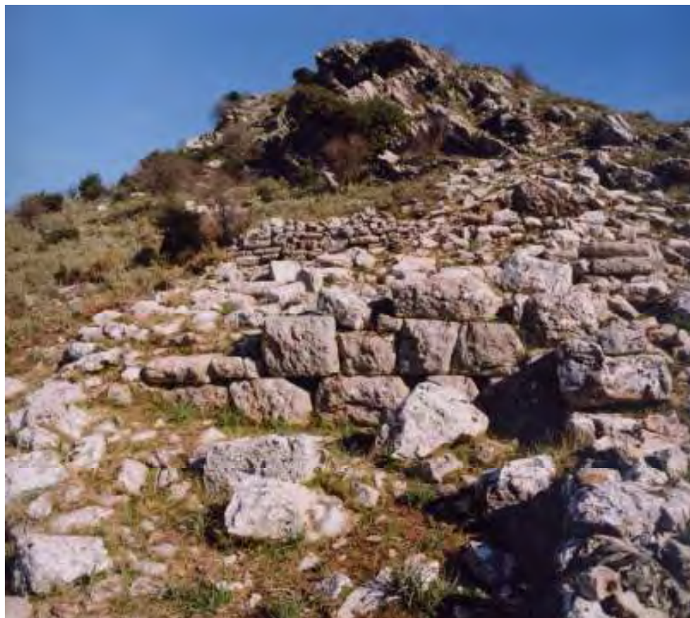
Εικ. 471/255. Οικισμός Κάτω Τριπόταμα Τριποτάμων Καλαβρύτων, θέση Αγραπιδιά Ελένης. Το προς Α τμήμα του τείχους, από Δ
