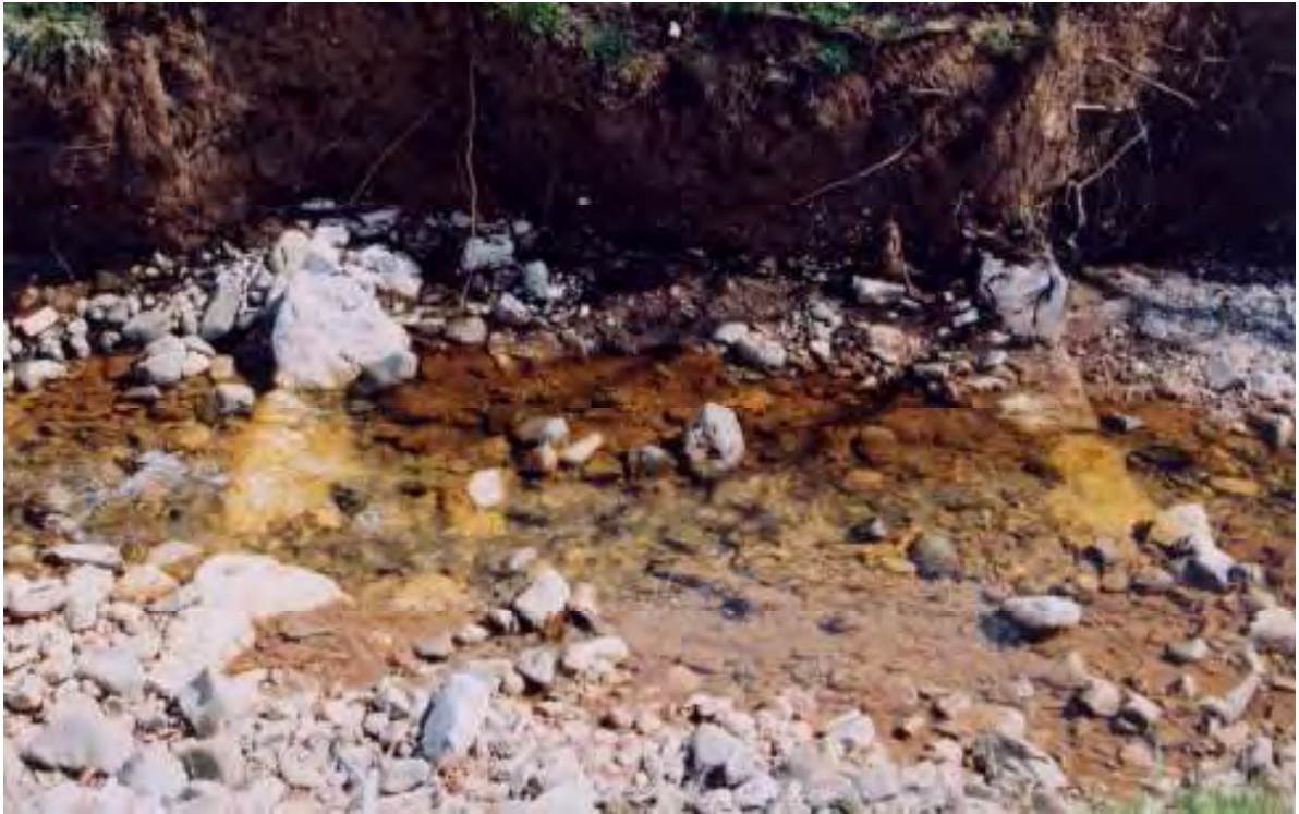
Εικ. 304/167. Άνω Κλειτορία (παλ. τοπων. Καρνέσι) Καλαβρύτων, θέση Κοίτη ποταμού Καρνέσιου. Τμήμα μεσοπυργίου διαστήματος της ανατολικής πλευράς του τείχους στην κοίτη του ποταμού. Ο ανώτερος δόμος παρασύρθηκε από την ορμητικότητα του ποταμού
