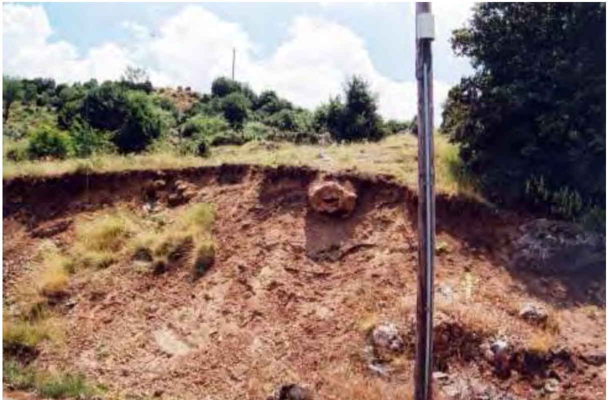
Εικ. 104/56. Καλάβρυτα, θέση (Επαρχιακή οδός Καλαβρύτων – Λουσών – Κλειτορίας). Τμήμα αγωγού κυκλικής διατομής, στην αριστερή/βόρεια πλευρά της οδού
