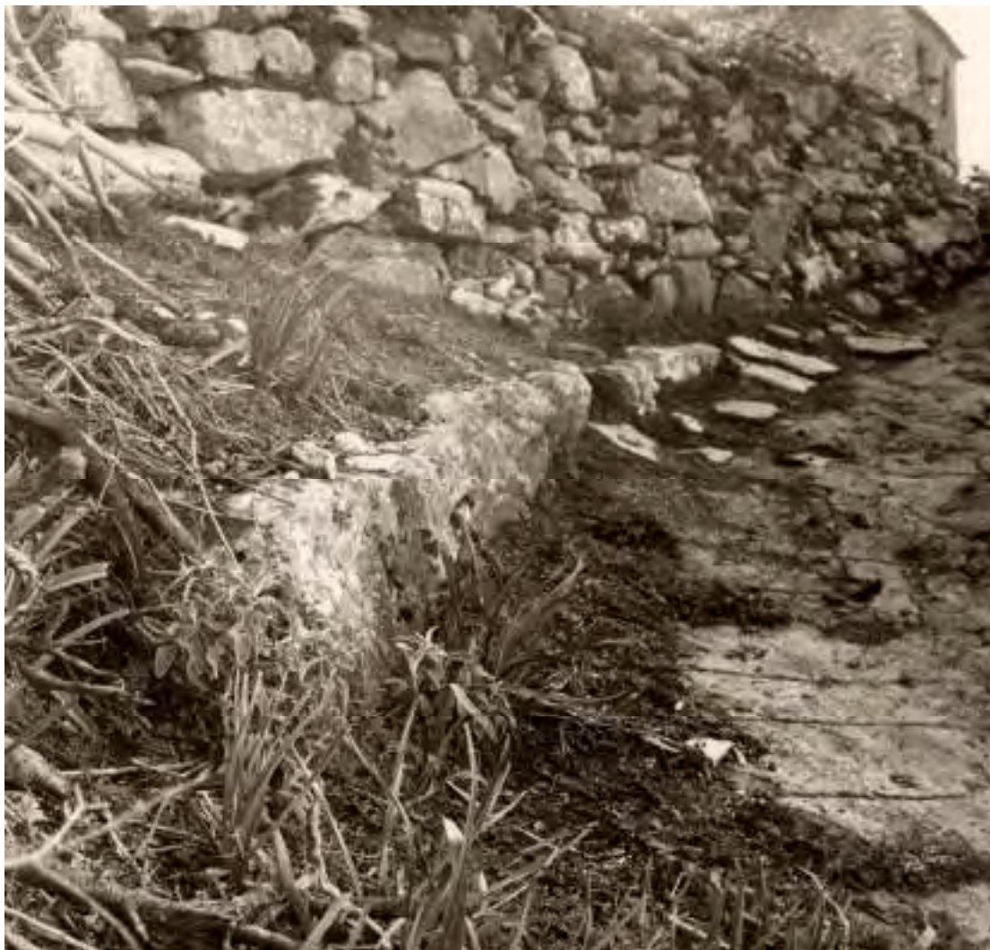
Εικ. 395/245. Οικισμός Κάτω Τριπόταμα Τριποτάμων Καλαβρύτων, θέση Βασιλική. Θεμέλιο κτηρίου στον αύλειο χώρο της οικίας Ι. Νικολακόπουλου
