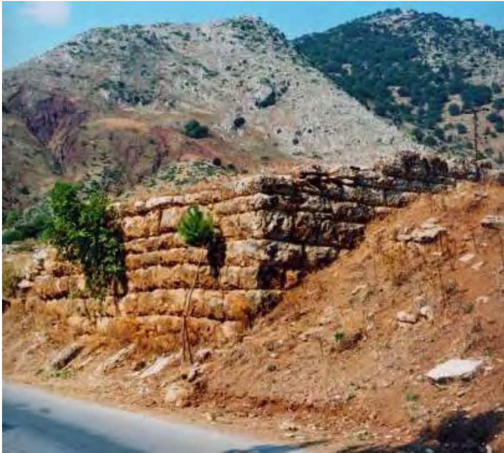
Εικ. 472/257. Οικισμός Κάτω Τριπόταμα Τριποτάμων Καλαβρύτων, θέση Ελληνικό. Η νότια και δυτική πλευρά του κτηρίου, από ΝΑ
