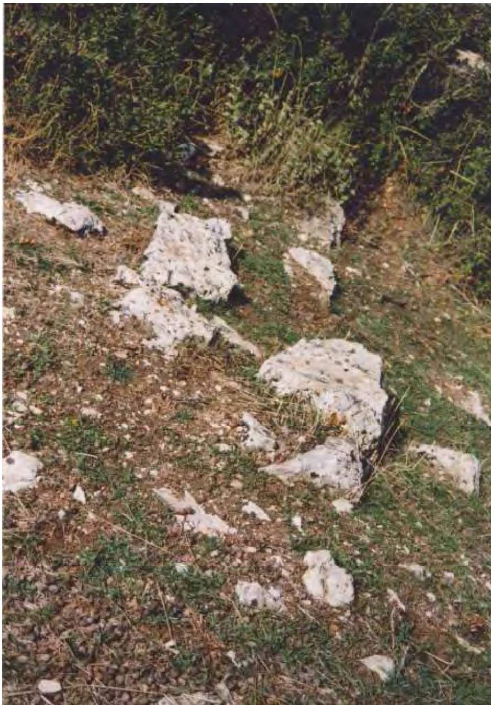
Εικ. 37/1. Βίλιβίνα Καλαβρύτων, θέση Άγιος Κωνσταντίνος. Κατάλοιπο τοίχου, από Ν
