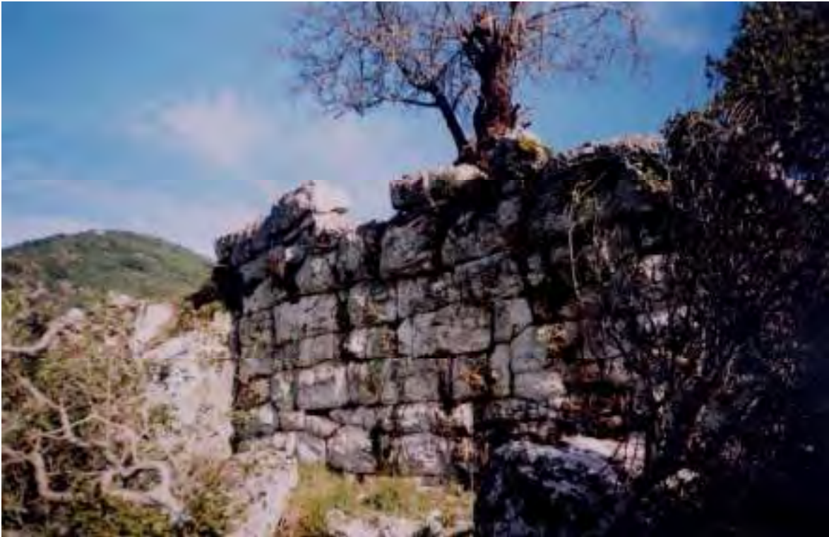
Εικ. 535/299. Πάος (παλ. τοπων. Σκούπι) Καλαβρύτων, θέση Σκουπίτσι, ή Σκουπίτσα. Άποψη τμήματος της Α/ΒΑ πλευράς της οχύρωσης, από ΝΑ
