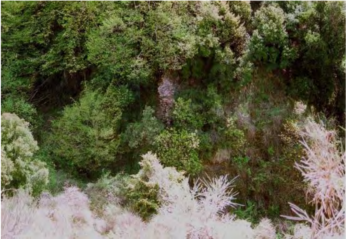
Εικ. 151/70. Καλάβρυτα, θέση Καμάρες, ή Βύθισμα. Τείχος στην αριστερή/νότια όχθη του ρέματος που κατέρχεται από το βουνό Πριόνι, ο οποίος πιθανόν ανήκει σε πεσσό του υδραγωγείου της Κύναιθας
