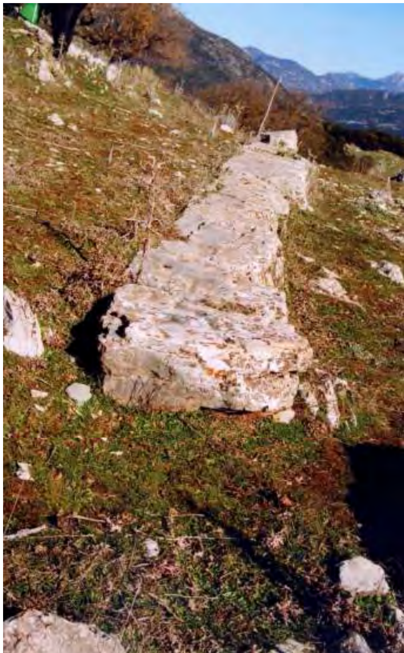
Εικ. 600. Ο τοίχος του κτηρίου V, από N/NA
