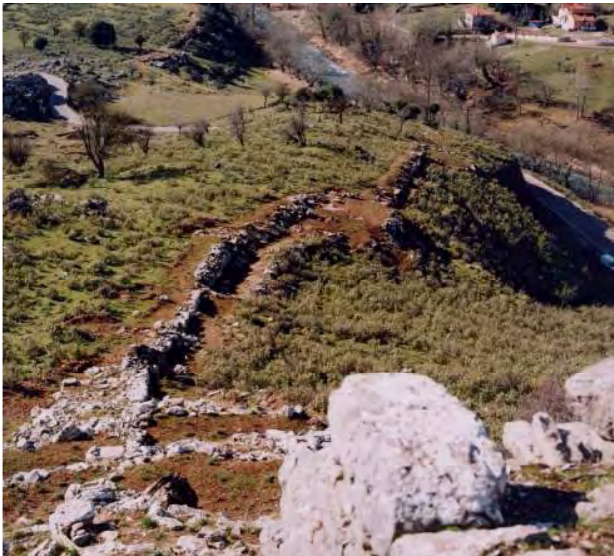
Εικ. 469/255. Οικισμός Κάτω Τριπόταμα Τριποτάμων Καλαβρύτων, θέση Αγραπιδιά Ελένης. Άποψη του τείχους από Α, μετά τις εργασίες αποψίλωσης
