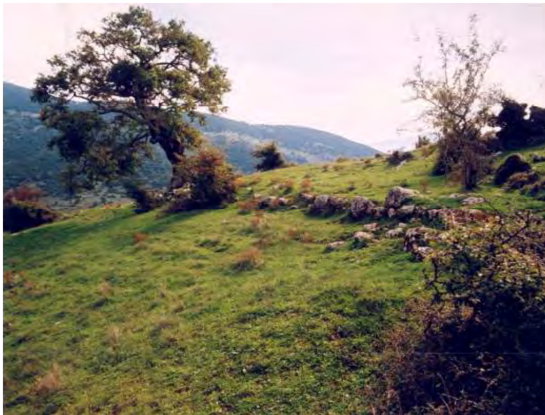
Εικ. 576. Άποψη του μεσοπυργίου διαστήματος της Β οριζόντιας πλευράς του τείχους, τμήμα Δ-Α, μετά τον πύργο 9
