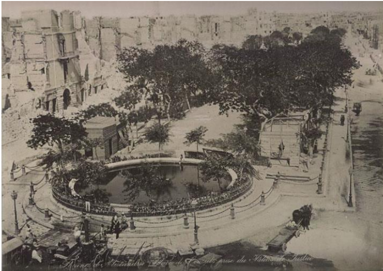
Εικόνα 8.9: Αποψη της πλατείας Μοχάμεντ Άλι μετά τον βομβαρδισμό
