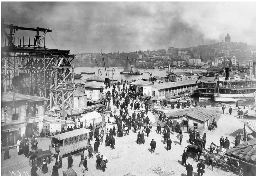
Εικόνα 6.10: Αποβάθρα στην περιοχή Korpusu στο Γαλατά
