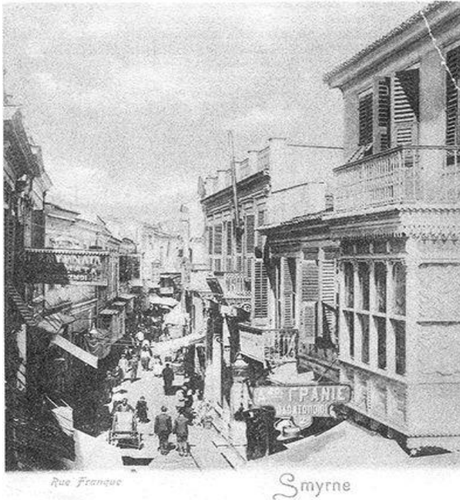
Εικόνα 4.9: Άποψη της οδού Φράγκων
