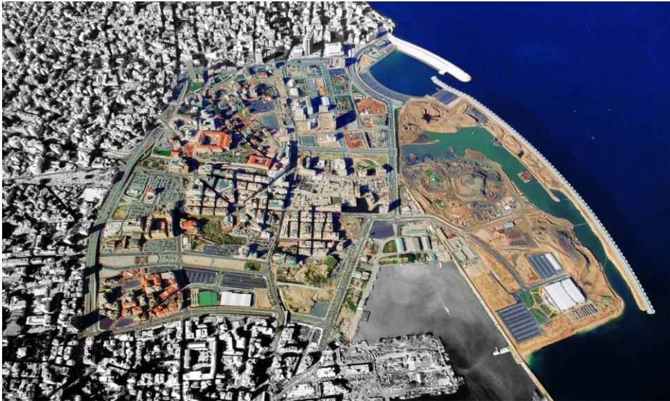
Εικόνα 7.45: Πανοραμική άποψη της περιοχής ανασυγκρότησης του SOLIDERE
