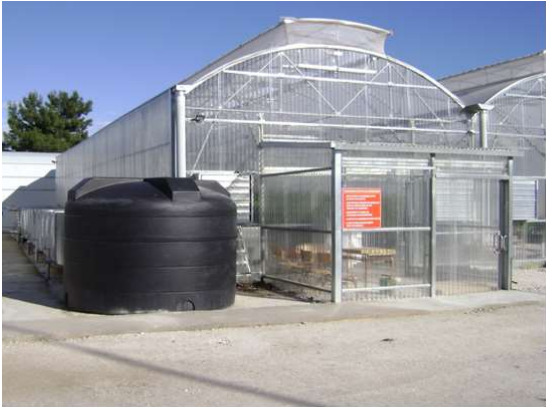
Εικόνα 22. Θερμοκήπιο Γεωθερμίας του Πανεπιστημίου Θεσσαλίας, Γαϊόπολις (Θάλαμος Α )
