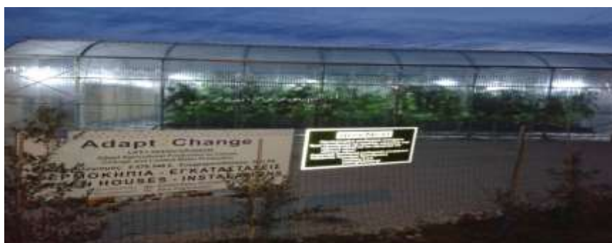
Εικόνα 21. Θερμοκήπιο Γεωθερμίας του Πανεπιστημίου Θεσσαλίας στο Campus της Γαϊόπολης.
