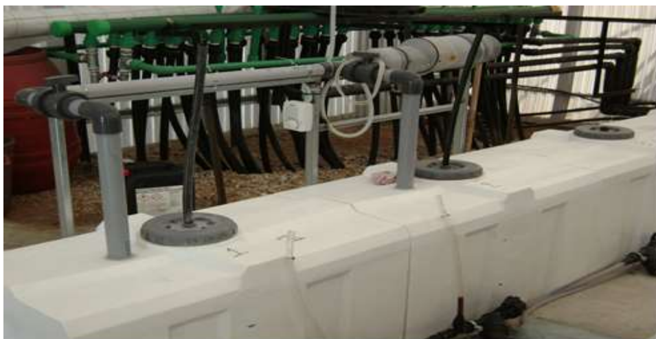
Εικόνα 25. Σύστημα παρασκευής του θρεπτικού διαλύματος με αναδευτήρα (αριστερά δοχείο 1, στη μέση δοχείο 2, δεξιά δοχείο 3)
