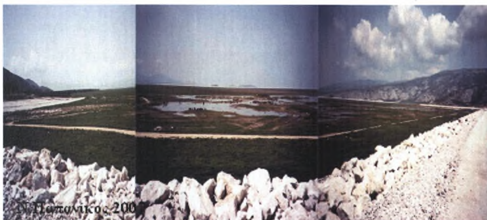
Φωτογραφία 6. Ο Ταμιευτήρας μετά την ολοκλήρωση του
