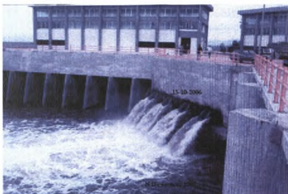
Φωτογραφία 14. Αντιπλημμυρικό-αποστραγγιστικό αντλιοστάσιο DP1 και άρδευσης Αο.
