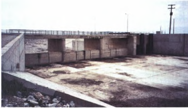
Φωτογραφία 9. Εξωτερική πλευρά του Συλλεκτήρα Σ3.
