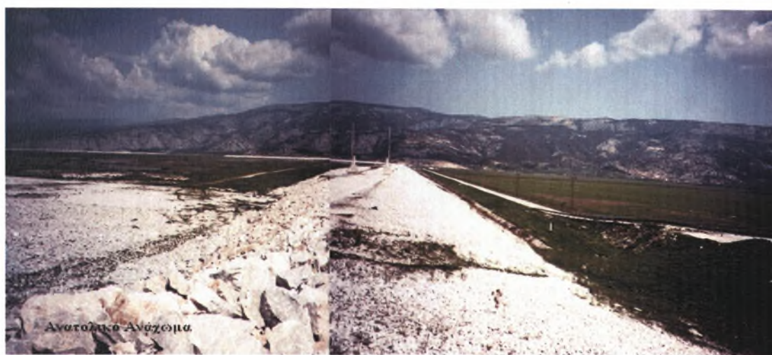
Φωτογραφία 5. Ανατολικό ανάχωμα Ταμιευτήρα
