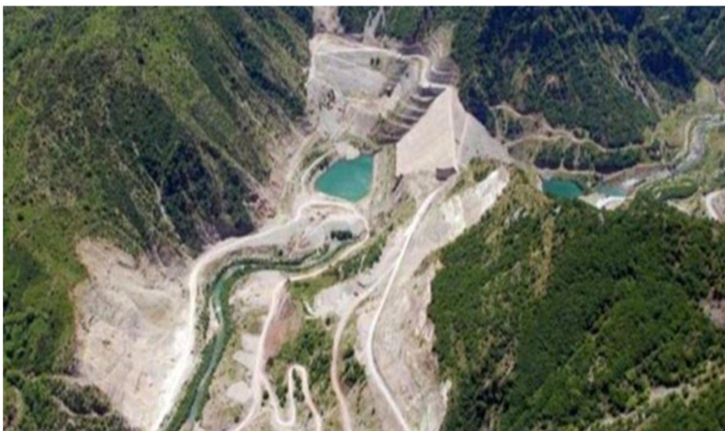
Εικόνα 10 : Υδροηλεκτρικό φράγμα της Μεσοχώρας Τρικάλων ( http://www.trikalaenimerosi.gr/blog/eidiseis/an-ypoyrgos-perivallontos-irthe-i-ora-na-leitoyrgisei-to-ydroilektriko-tis-mesoxoras )
