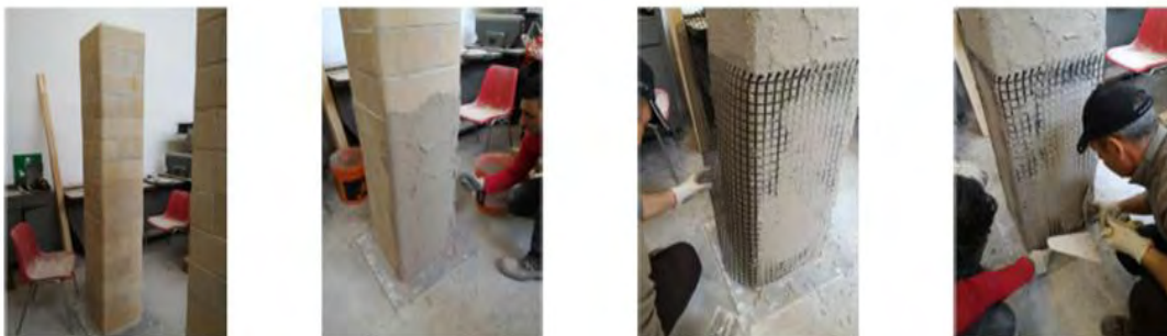
3.23 Διαδικασία ενίσχυσης υποστυλώματος τοιχοποιίας με IAM (Maddaloni et al., 2015)
