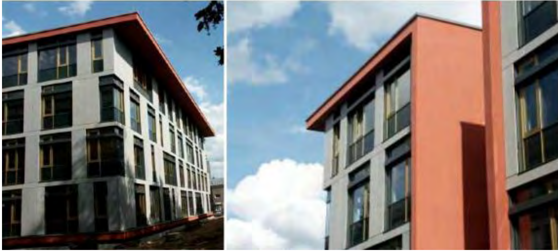
Σχήμα 3.3 Κάλυψη επιφανειών με στοιχεία IAM σε σχολείο στο Ντίσελντορφ [ http://materia.nl/ ]
