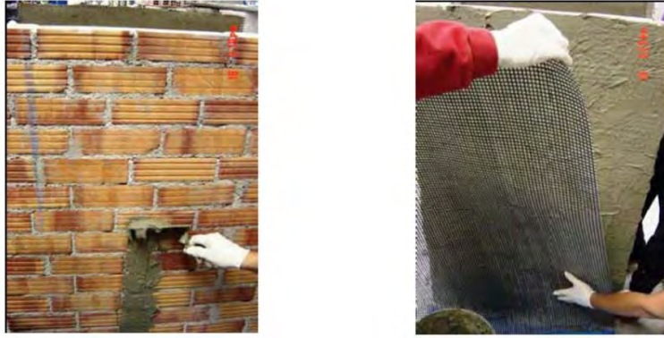
Σχήμα 3.19 Διαδικασία ενίσχυσης τοιγίσκων με ΙΑΜ (Παπανικολάου και Τριανταφύλλου, 2009)
