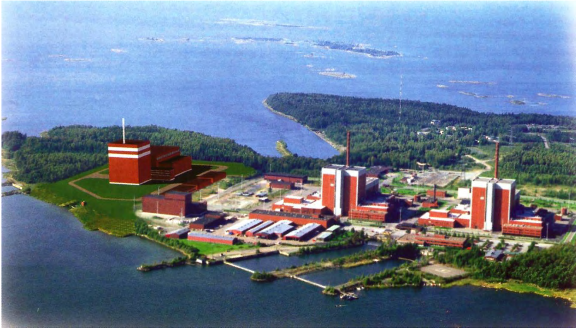
Εικόνα 19: Πυρηνικός Αντιδραστήρας στο Olkiluoto της Φινλανδίας
