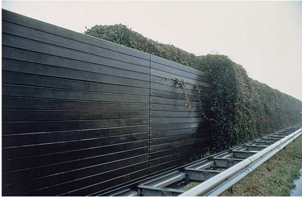
Εικόνα 2. Συνδυασμός ξύλινου ηχοπετάσματος με φυτεμένη κατασκευή με τη μορφή κατακόρυφου κήπου. Πηγή: (Kotzen and English, 2009)
