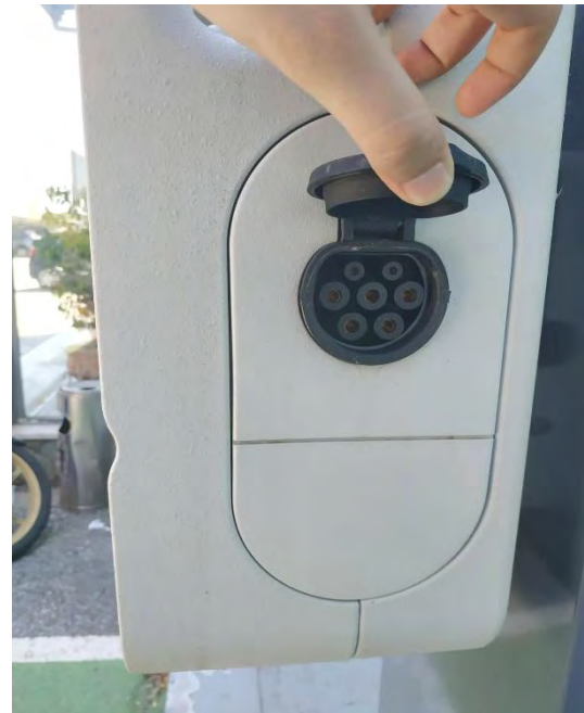
Εικόνα 25. Υποδοχή ρευματολήπτη τύπου 2 για γρήγορη φόρτιση έως 43 kW, στο κατάστημα GERO
