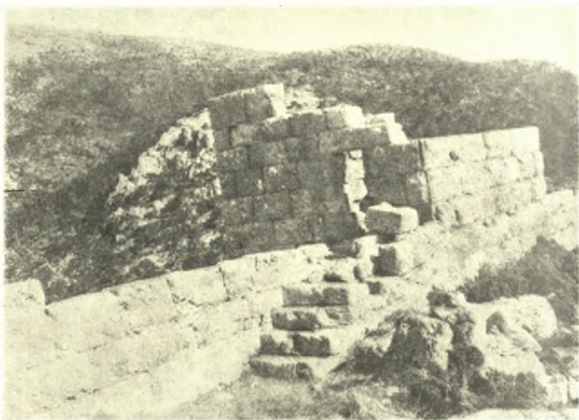
Εἰκ. 7. Ἀποκαλυφθεῖσα λιθίνη κλιμαξ ἀνόδου εἰς τὸν περιδρόμον καὶ τὸν πύργον (B πλευρά).
