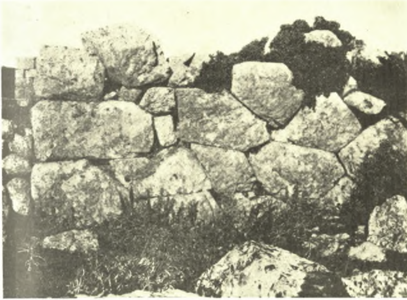
Εἰκ. 8. Δείγμα τῆς πολυγωνικῆς δομῆς τοῦ ὀρθογωνίου κτίσματος.
