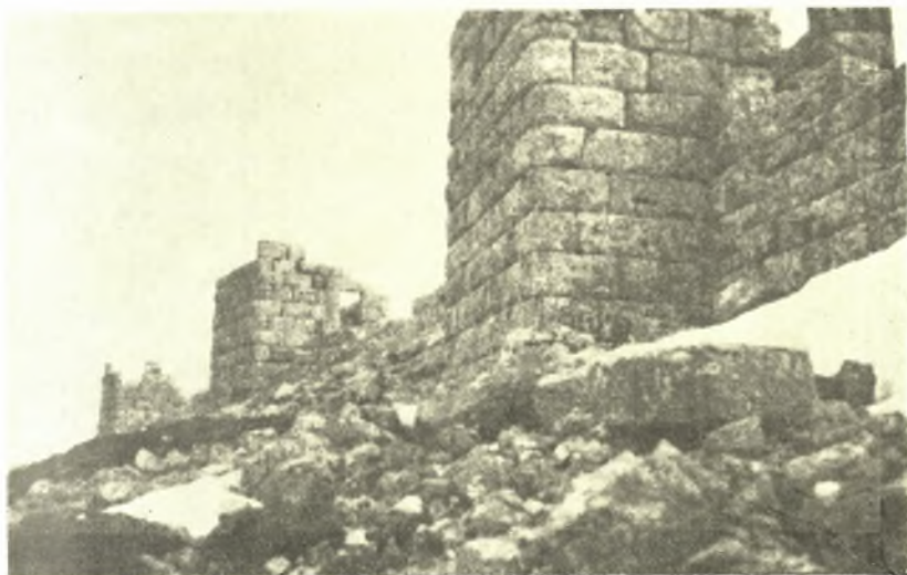
Εἰκ. 3. Πύργοι καὶ μεταπύργια τῆς βορείου πλευρᾶς, ὁρώμενα ἐξωτερικῶς.
