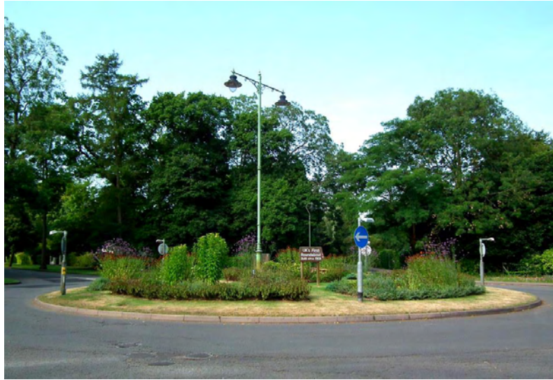
Εικόνα 2.1-1: Φωτογραφία του πρώτου κυκλικού κόμβου του Ηνωμένου Βασιλείου, κατασκευάστηκε το 1909 (Πηγή: https://hiveminer.com/Tags/letchworth%2Croundabout )
