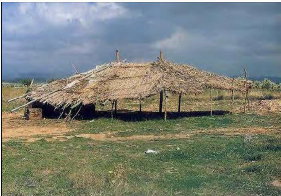
Εικόνα 86: Στέγαστρο με ξύλινο σκελετό και κάλυψη από πλεγμένα κλαδιά.
