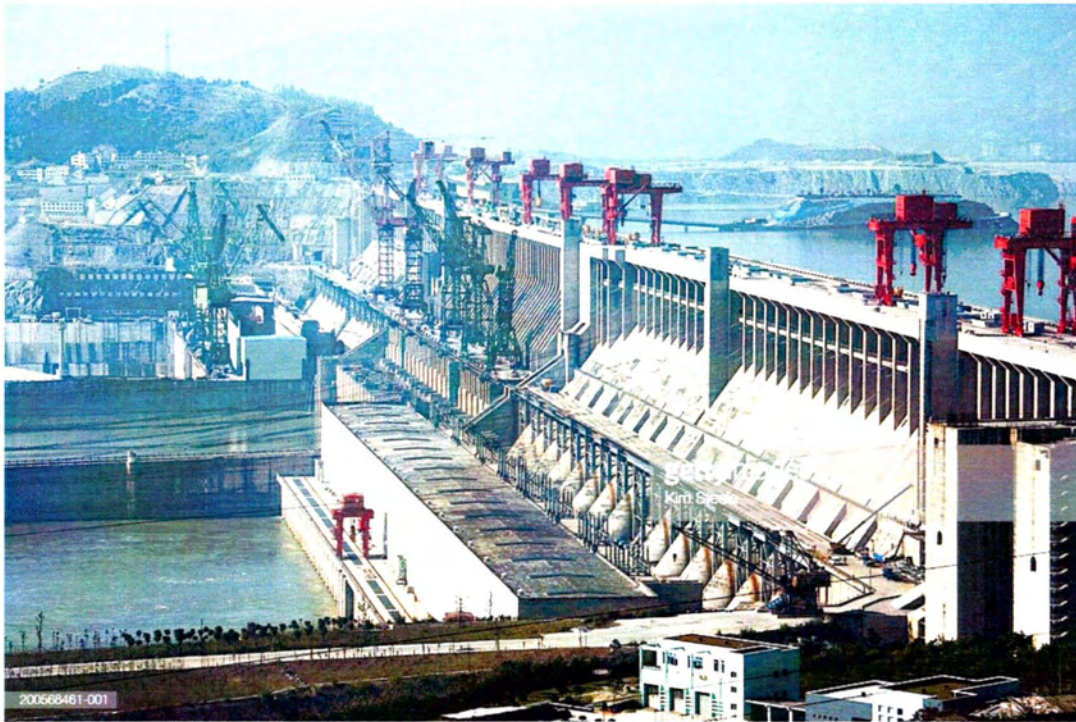
Εικόνα 6: Σταθμός Υδροηλεκτρικής Ενέργειας στο Three Gorges Dam, Wuhan, China
