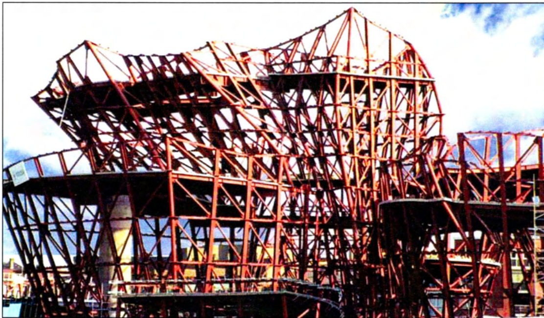
Εικόνα 25: Το Μεταλλικό δικτύωμα/ Φέρων οργανισμός
