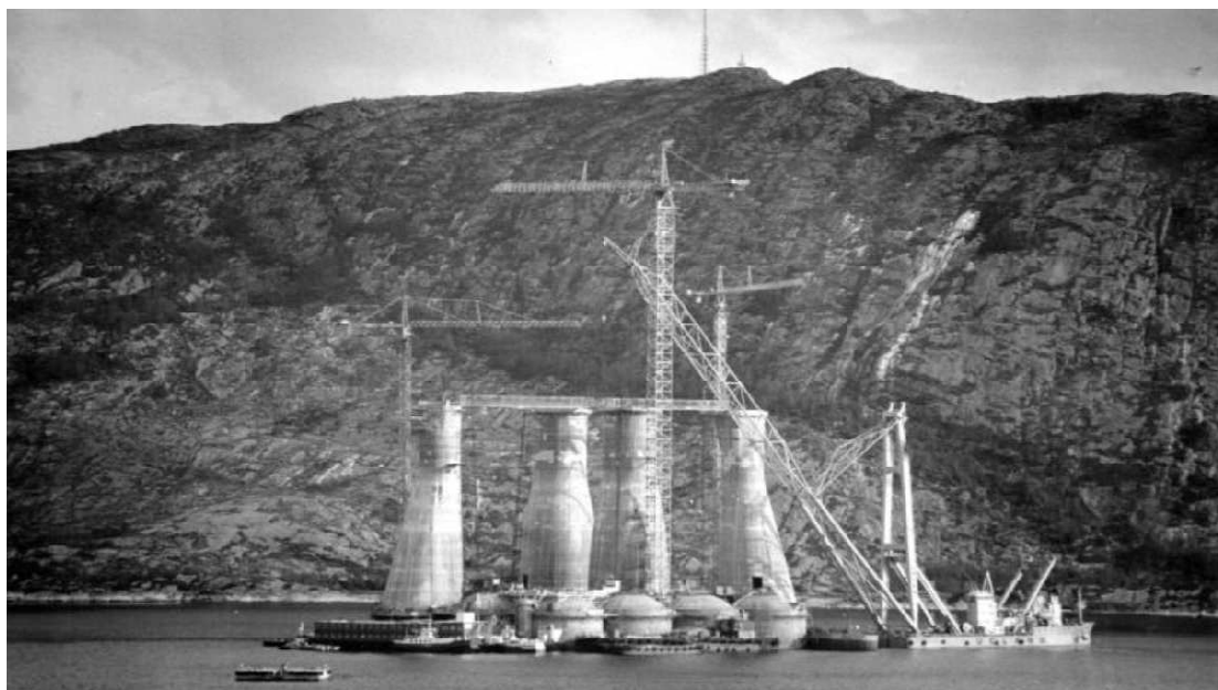
Εικόνα 3.1: Πλατφόρμα εξόρυξης πετρελαίου και φυσικού αερίου Sleipner A στη Βόρεια Θάλασσα (Statoil, διαδίκτυο)
