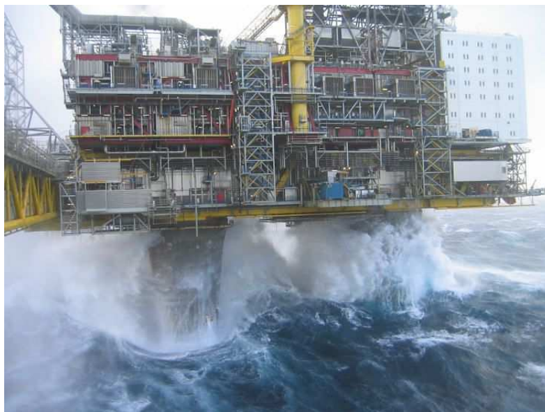
Εικόνα 1.2: Πλατφόρμα πετρελαίου σε συνθήκες κυματικών φορτίσεων (Oseberg oil rig στη Βόρεια Θάλασσα, διαδίκτυο)
