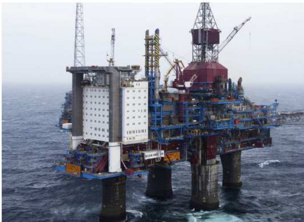
Εικόνα 3.2: Πλατφόρμα Sleipner A στη Βόρεια Θάλασσα (Καρυπίδης, 2015)
